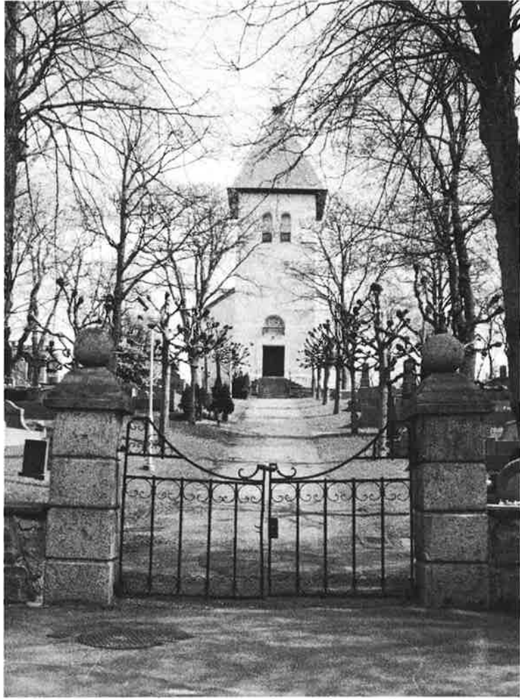
Entrén i väster med den gamla grinden och grindstolparna. Klippta lindar har planterats längs mittgången. (GSM 10-99, 2)
