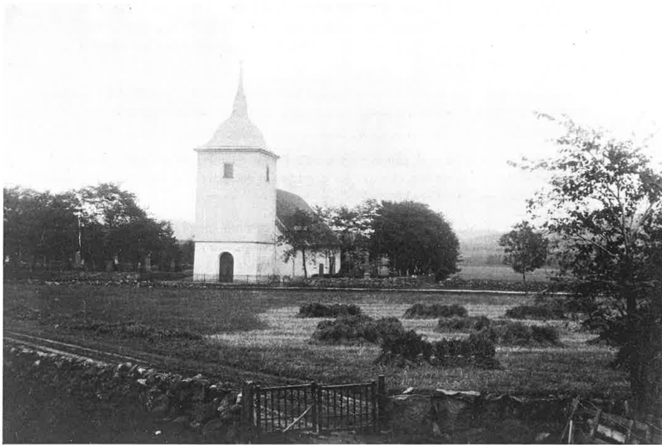
Säve kyrka med den äldre kyrkogården och söder om kyrkan. Framför kyrkporten finns ett järnstaket med grindar uppfört 1880. Detta nedrevs 1934 och ersattes med de grindar som idag finns på platsen. Bilden är utan årtal, men är sannolikt från 1900-talets början. (GSM bildarkiv)
