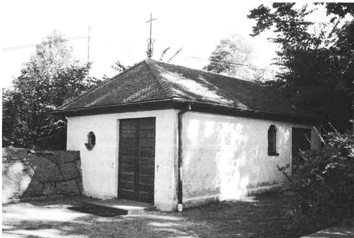
Bisättningsrum från 1950 efter ritningar av arkitekt Axel Forssén. (GSM 15-99,28)
