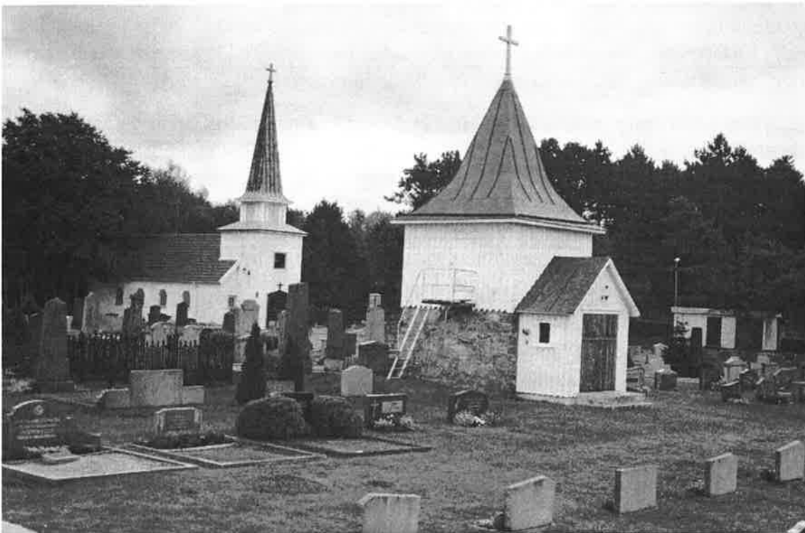
Öster om klockstapeln finns kyrkogårdens äldsta gravar. Gravsättningsområdet väster om byggnaden är relativt nyligen anlagt. (GSM 24-99,9)
