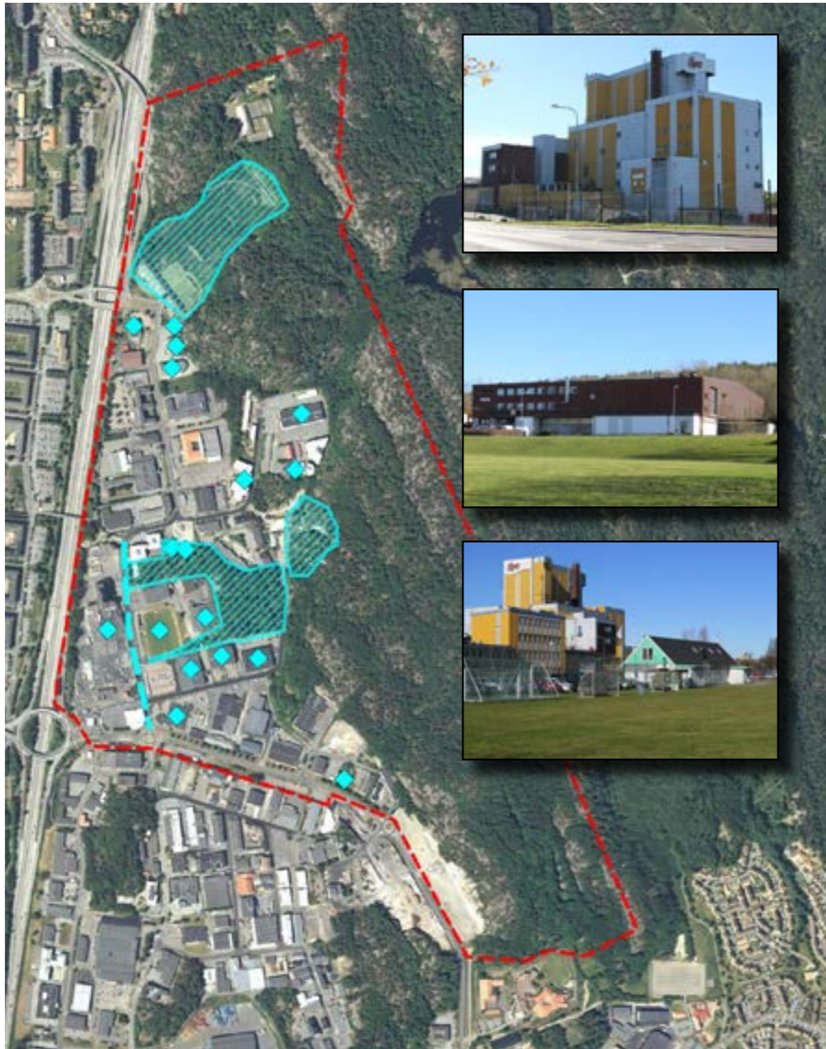
Fig 53: Illustration av strukturer och byggnader som är värdefulla och representativa för olika skeden i områdets utveckling. Deskrifferadeytorna visar från norr: skjutbanan, lämningar från pegmatitbrottets samt läget för Högsbo by. Till vänster syns ett parti av en äldre vägsträckning i form av en streckad linje. Punkterna visar representativa och bevarandevärda byggnader från olika skeden i områdets utveckling.
