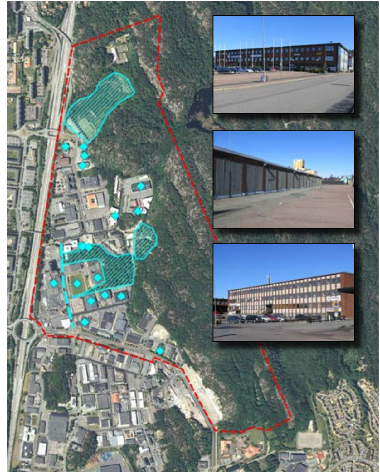
Fig 54: Illustration av strukturer och byggnader som är värdefulla och representativa för olika skeden i områdets utveckling. Deskrifferadeytorna visar från norr: skjutbanan, lämningar från pegmatitbrottets samt läget för Högsbo by. Till vänster syns ett parti av en äldre vägsträckning i form av en streckad linje. Punkterna visar representativa och bevarandevärda byggnader från olika skeden i områdets utveckling.
