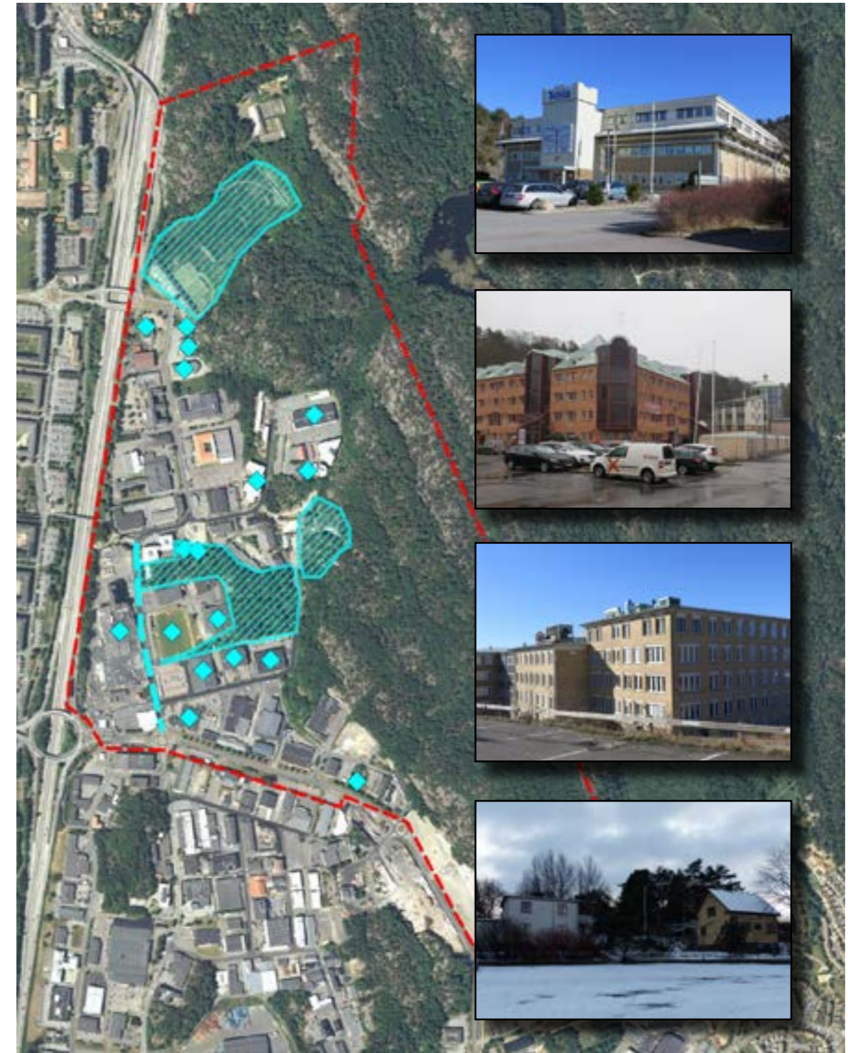
Fig 52: Illustration av strukturer och byggnader som är värdefulla och representativa för olika skeden i områdets utveckling. Deskrifferadeytorna visar från norr: skjutbanan, lämningar från pegmatitbrottets samt läget för Högsbo by. Till vänster syns ett parti av en äldre vägsträckning i form av en streckad linje. Punkterna visar representativa och bevarandevärda byggnader från olika skeden i områdets utveckling.
