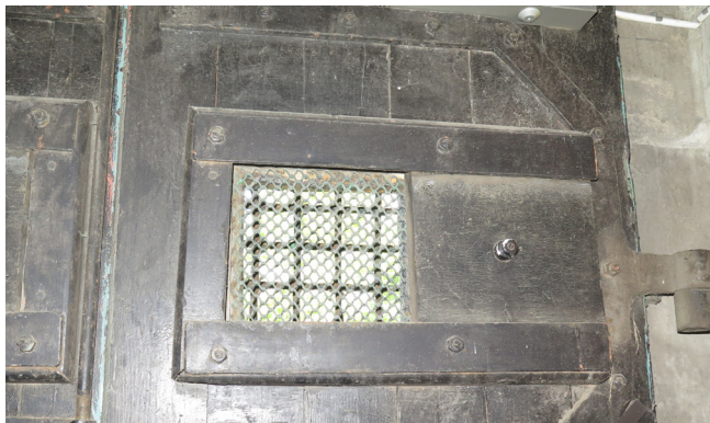
Lucka till fönsteröppning i porten
