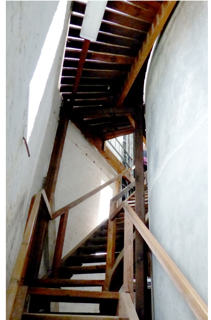
Trätrappan som leder runt cisternen och upp till tornets topp
