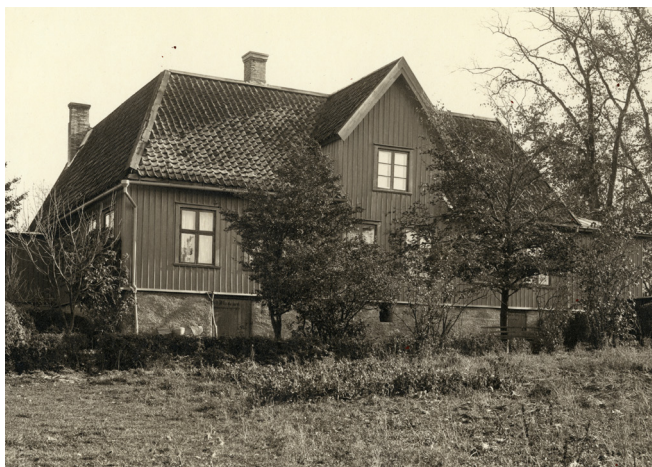
Gården Lundens mangårdsbyggnad år 1920.
