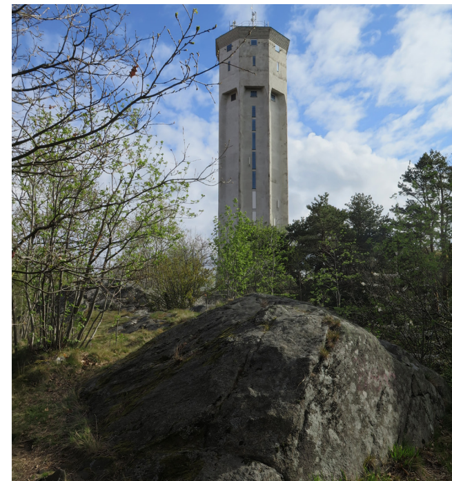
Vattentornet tornar upp sig från sin position på berget.
