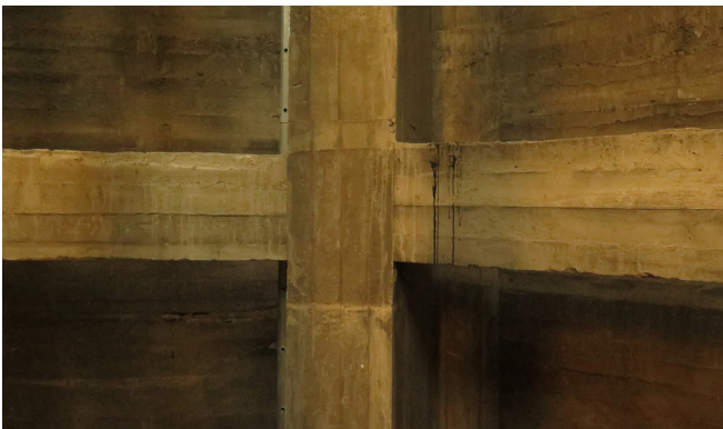
Väggen i "naken" formgjuten betong
