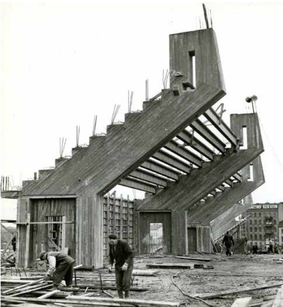
Bilder från utbyggnadsfasen 1957. Övre bilden visar täckningen av läktarna och nedre skildrar de formgjutna ramarna som utgör de bärande delarna i en läktare. Fotograf Tord Eliasson
