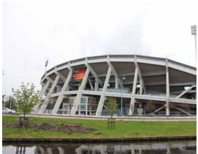
Ullevis sida mot fattighusån där den öppna, bärande konstruktionen framträder tydligt.
