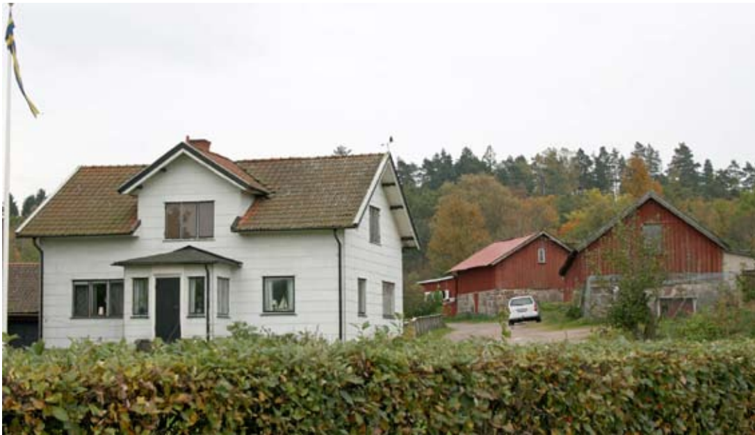
Ovan: Ett särskilt värde ligger i gårdsanläggningar som inbegriper så väl bostadshus som ladugård och uthus.
