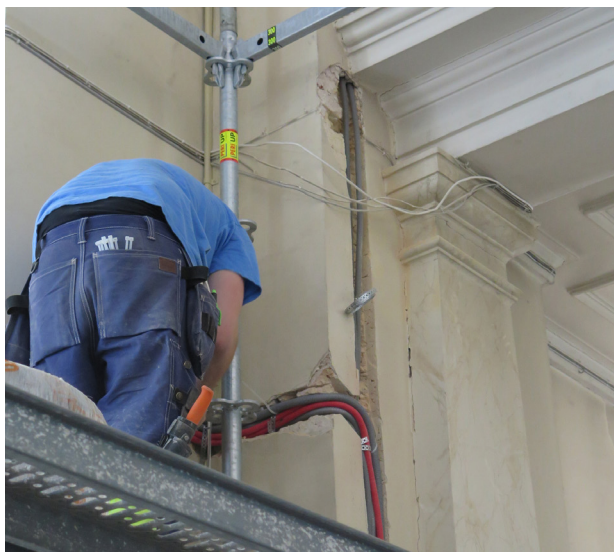
Ombyggnaden innefattade en hel del elarbeten för ny belysning på ett flertal ställen. Nya takkronor, belysning på altartavlan, runt kyrksalen, vid pelarna i koret, i fönstersmygar, belysning av orgeln etc. Ledningar bilades in i kyrkväggen.
