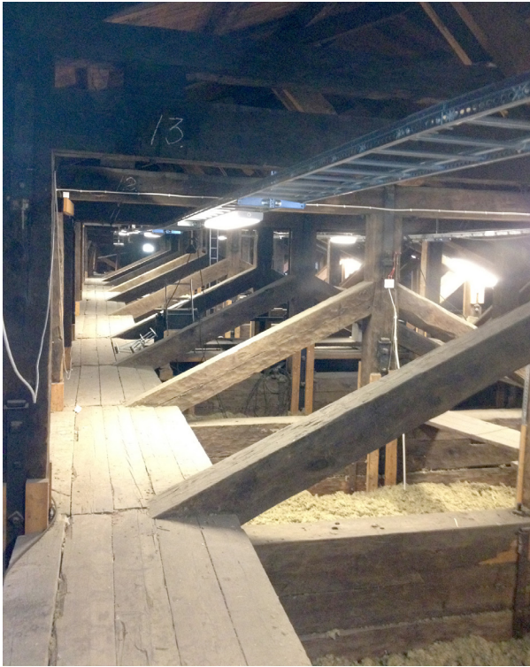
Bilden visar vinden över kyrkorummet före ombyggnaden, sett mot koret. Lägg märke till hammarbandens tjocklek.
