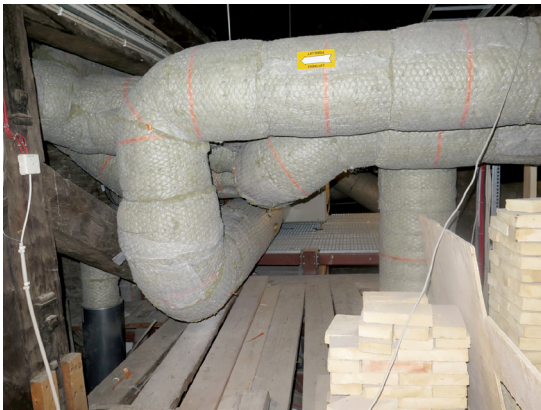
Bilden visar kyrkvinden efter ombyggnaden. Nya ventillationsanläggningar har installerats i tornet och på kyrkvinden. Ett frånluftsaggrigat har placerats i en tidigare fönsteröppning på vindens norra sida, längst väster ut. Fönsterbågen förvaras på vinden.
