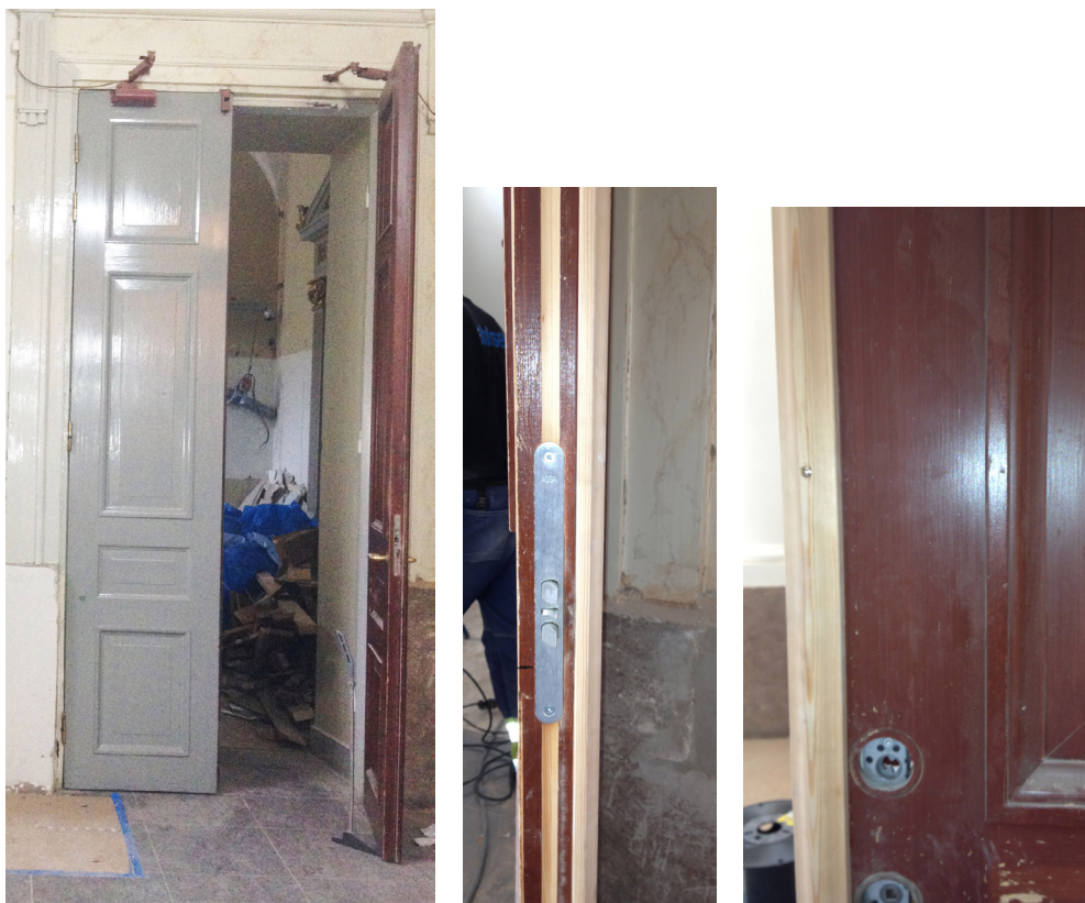
Teknik för bland annat automatisk öppning monterades in i kyrkorummets dörrar (dörr från 1904)
