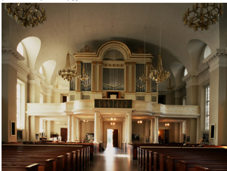
Kyrkorummet före ombyggnaden, sett mot orgelläktare och vapenhus. Vid ombyggnaden på 1980-talet gjordes som en tolkning av vad man medade var en ursprunglig färgsättning. Kolonner i gulröd färgton med piskteknik, bänkar ådermålade i mahogny och dörrar ådrade i ek.
