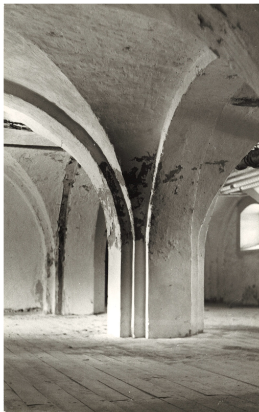
Manbyggnadens valvslagna källare, dokumenterad innan rivning. Ur Gamla kontoret vid Gamlestadens fabriker AB.
