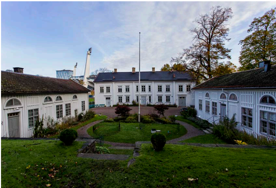
Huvudbyggnaden och två flygelbyggnader från söder, från den övre delen av terrasseringen som skiljer gårdsplanen från den engelska parken och köksträdgården. Foto: Ola Eriksson. Se även sid. 13
