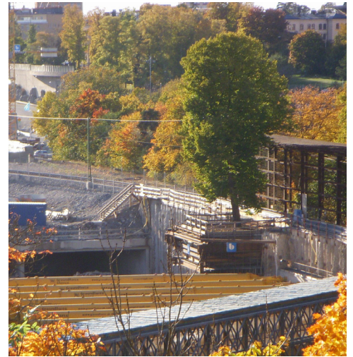
Skydd av träd under bygge av Norra länken i Stockholm, foto Holger Ellgaard
