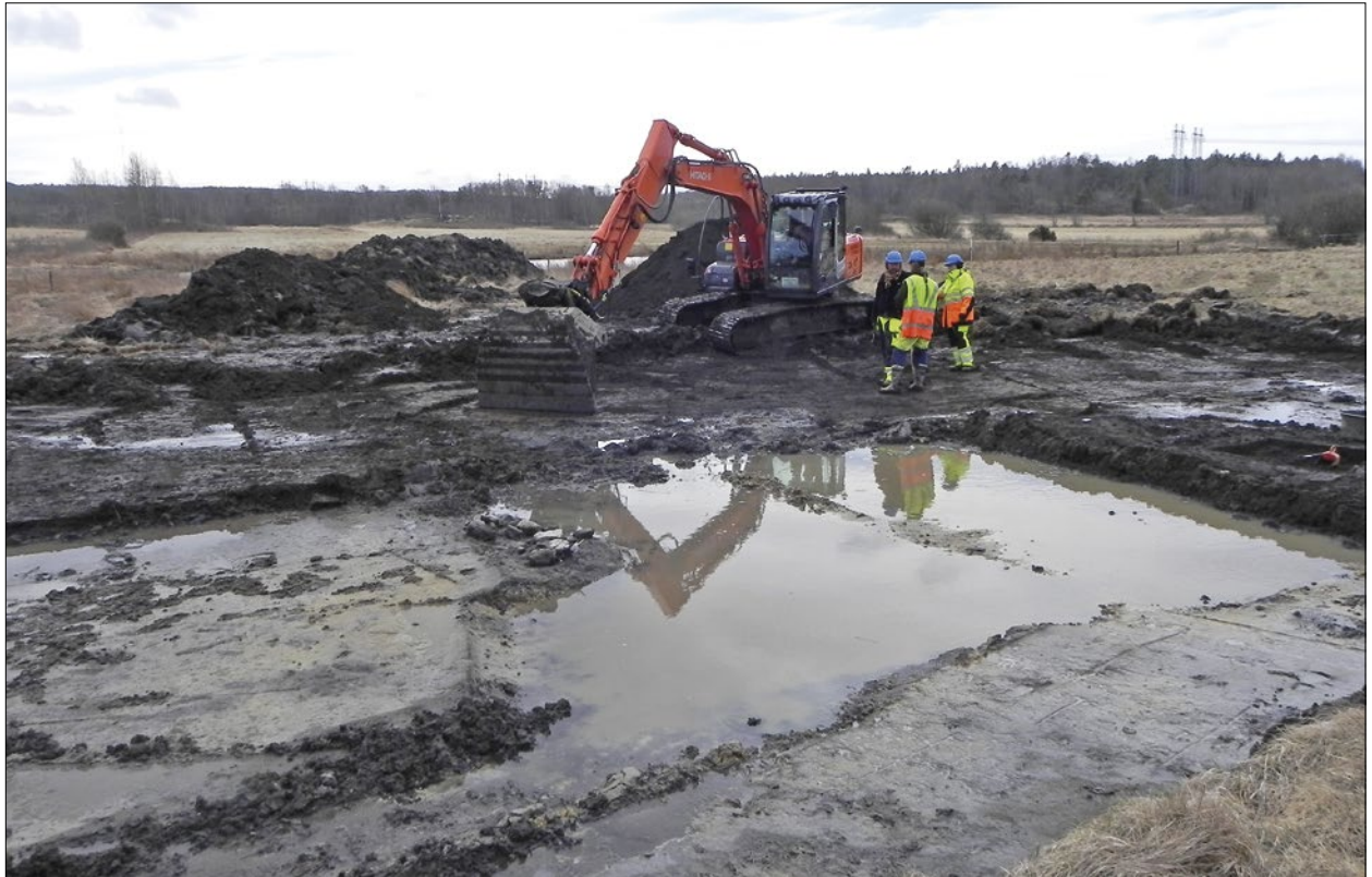
Figur 17. Schaktningen försvårades av regn, tjäle och dålig avrinning. Foto: Sara Lytkens.
