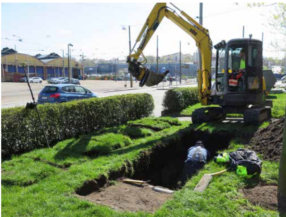
Figur 26. Undersökning av schakt 27, där avtryck av en damm påträffades.
