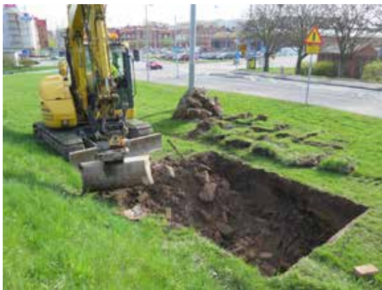
Figur 28. Grävning av schakt 28. Foto mot nordost.
