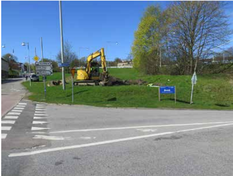
Figur 30. Grävning av schakt 29. Foto mot väster.
