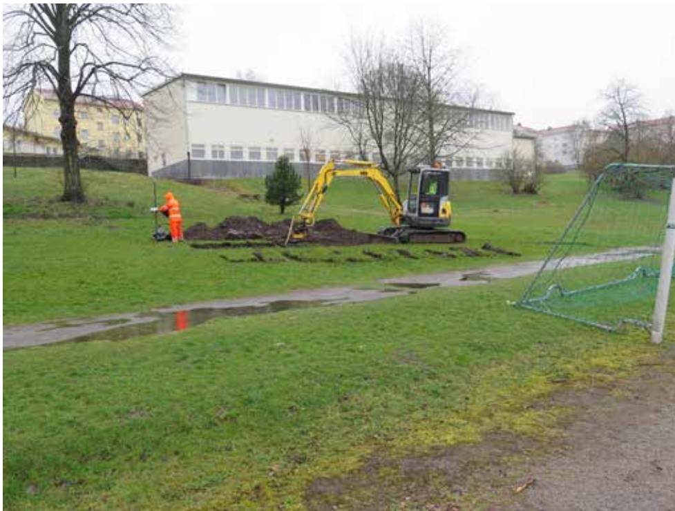
Figur 18. Undersökning av schakt 5 nedanför Sannaskolan. Foto mot sydost.
