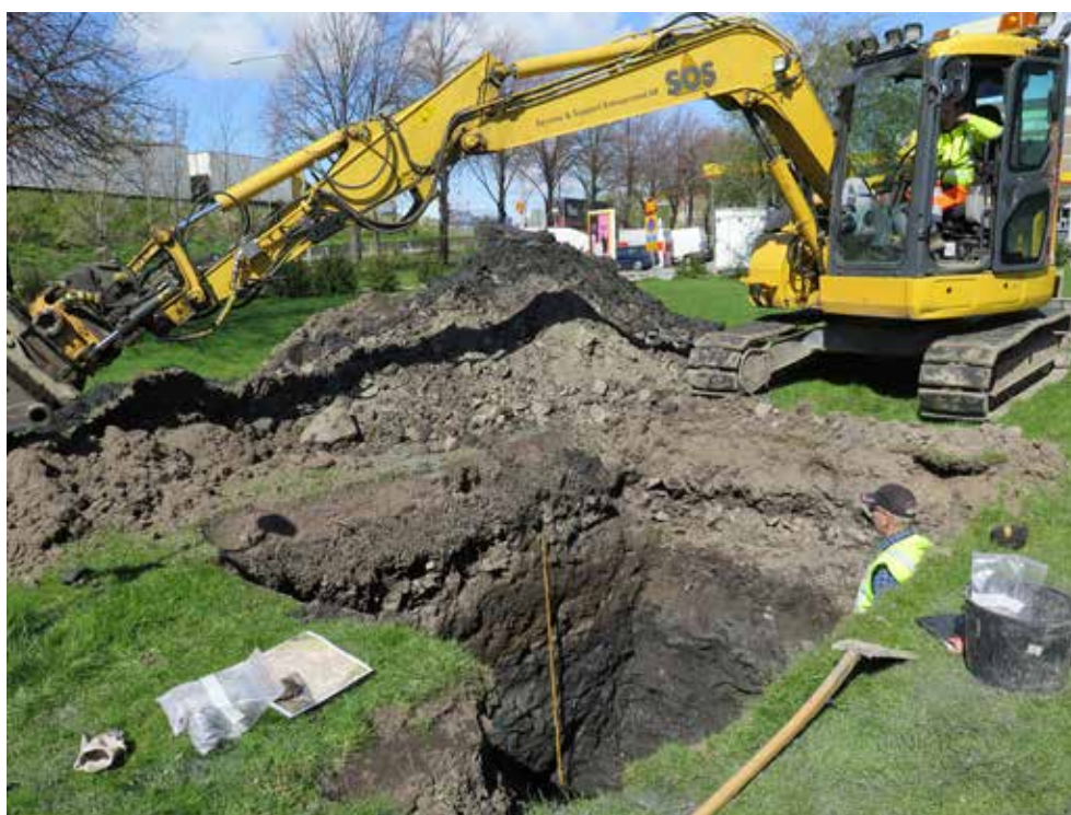
Figur 34. Grävning av schakt 30. Foto mot norr.
