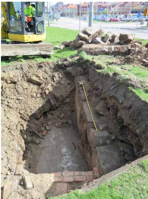
Figur 29. Husgrund i schakt 28. Foto mot nordost.
