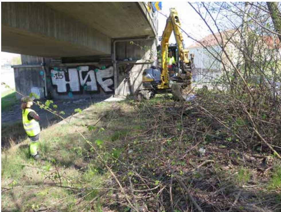
Figur 23. Förberedelser för grävning av schakt 22. På bilden ses Karolina Kegel. Foto mot nordost.
