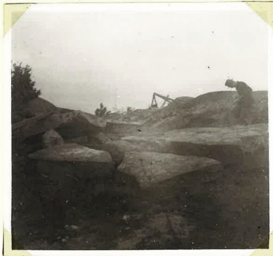
Foto 4. B4334 Efter plåt n:r a 1242. Gånghällens och sakhällarnas läge före restaureringen. Från S.
