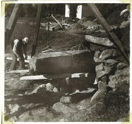
Foto 6. B4336 Efter plåt a 1244. Stekhällen till gängen placeras i sitt läge. Från Ö.
