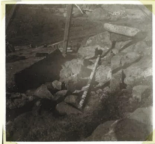
Foto 5. B4335 Efter plåt a 1243. Under pågående restaurering. Gångens sidohällar placerade i ursprungligt läge före Gustafsons undersökning 1884. Från Ö.
