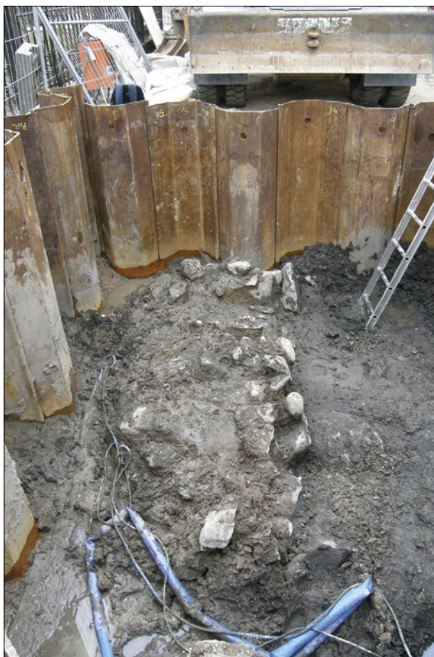
Figur 13. Inledningsvis grävdes det första kulturlagret. I samband med det framkom kanten på muren tydligare. Ytan på muren rensades på lös jord och det övre skiktet på murstenen frilades. Foto, mot norr: Carina Bramstång Plura.
