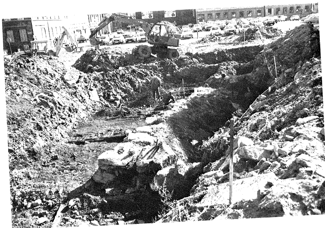
Fig. 49, Kvarteret Vindragaren, Mur C, muren sträcker sig över hela bilden, anl 1a är framgrävd och anl 4 undersökes. Kvarteret Enigheten är i grävningsperiodens början parkeringsplats. Foto mot söder. Foto : EJ -79
