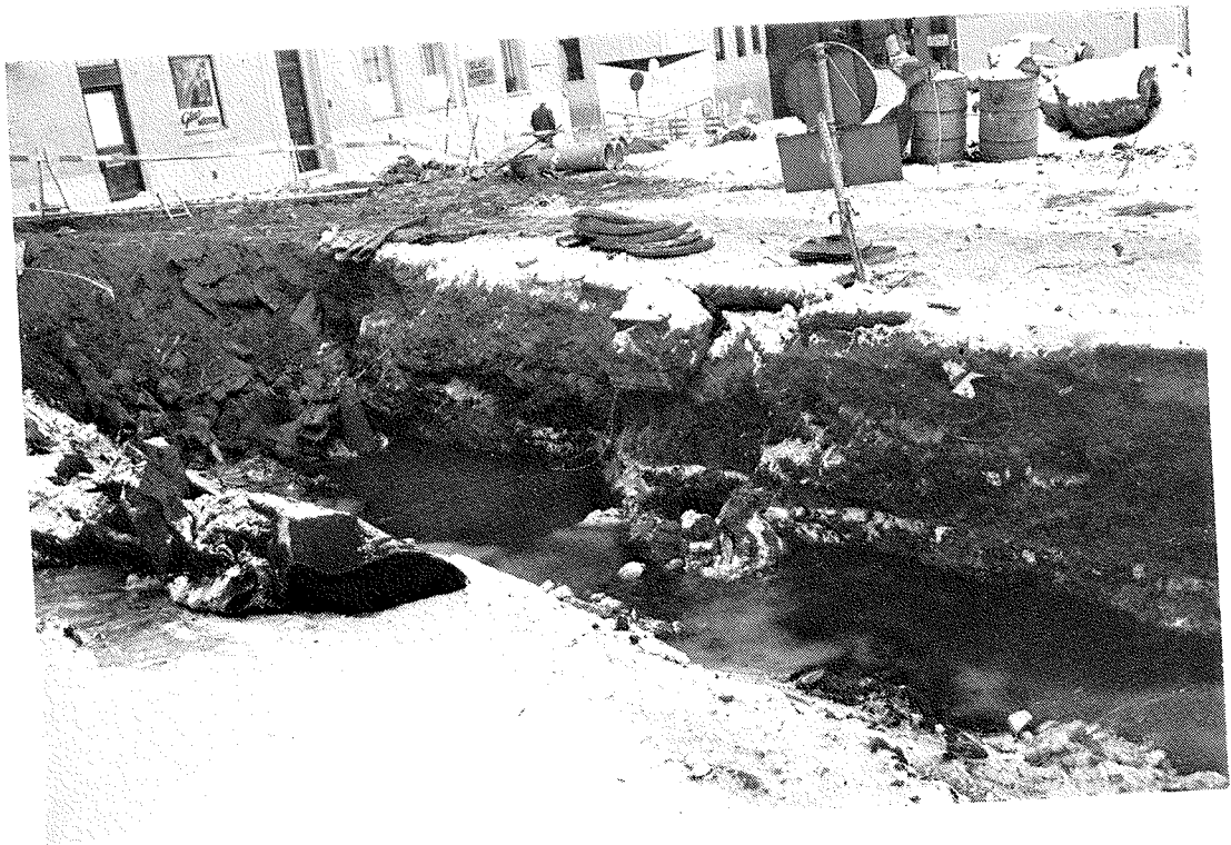
Fig. 74, Kvarteret Stadskvarnen anl 1, avfallssaml/ kulturlager. Foto mot nordost. Foto: SK -80
