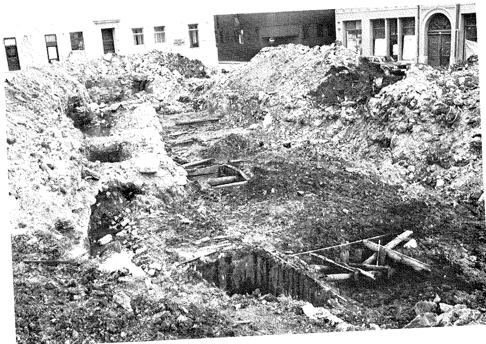
Fig. 48, Kvarteret Vindragaren, mur C. Mur C syns i fotots vänstra del. I nedre delen finns anl 7 och anl 8. Foto mot norr. Foto: EJ -79
