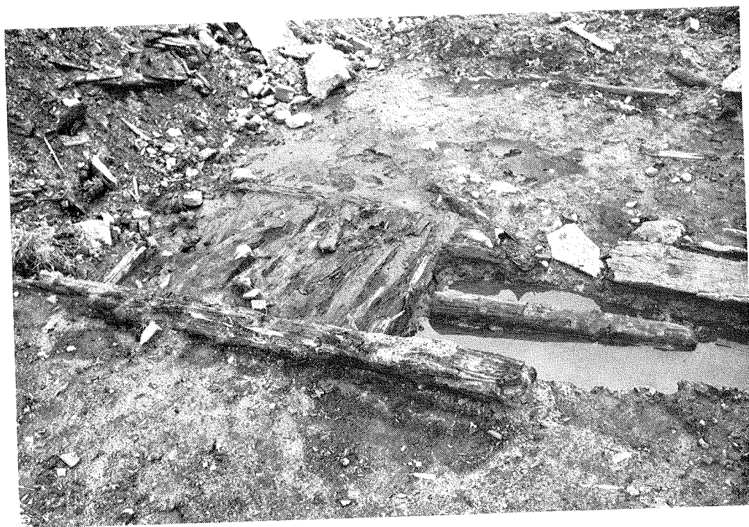
Fig. 54, Kvarteret Vindragaren, anl 1a, trägolv med syll- stockar. Foto mot söder. Foto: SK -79
