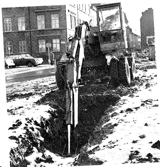
Fig. 46, Kvarteret Vindragaren Schakt III. Uppgrävning av schakt. Foto mot sydost. Foto: SW -79
