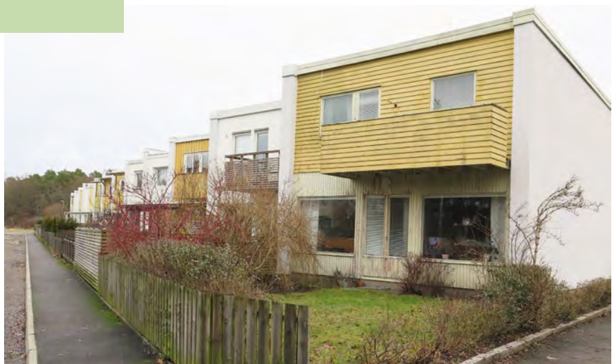
Figur 61. Radhuslängan med zig-zag form och i förgrunden den ursprungliga fasadbeklädnaden.
