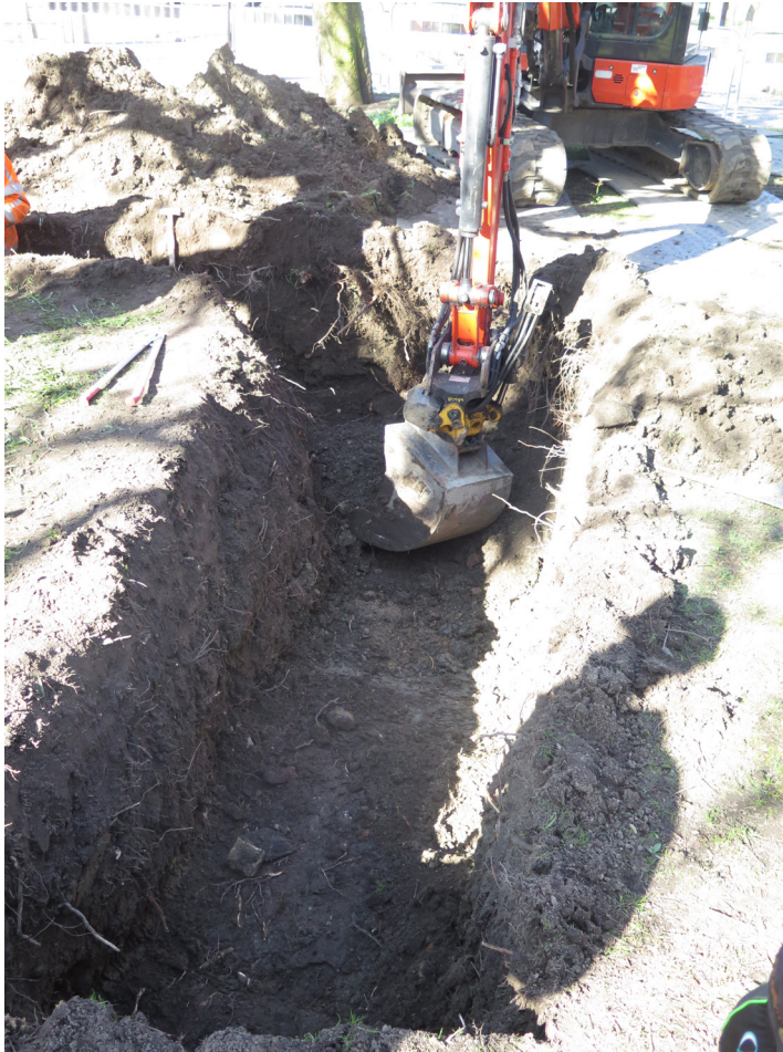
Figur 12. Schakt för trädrotsbeskrining vid träd 565. Foto mot norr.
