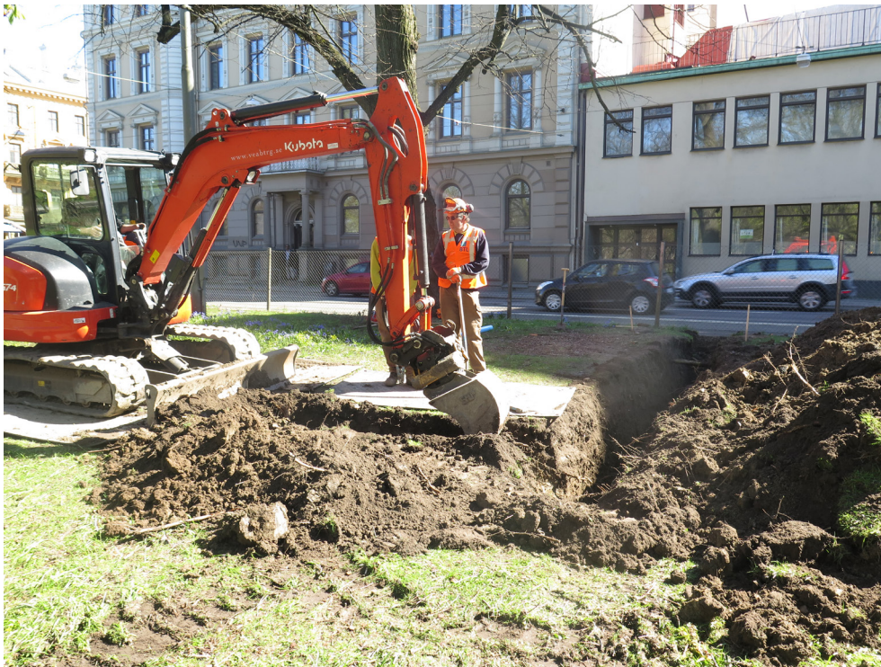
Figur 11. Schakt för trädrotsbeskärning vid träd 562. Foto mot söder.
