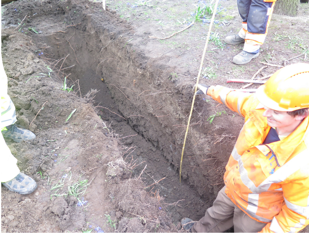
Figur 10. Schakt för trädrotsbeskrining vid träd 608. Foto mot nordost.
