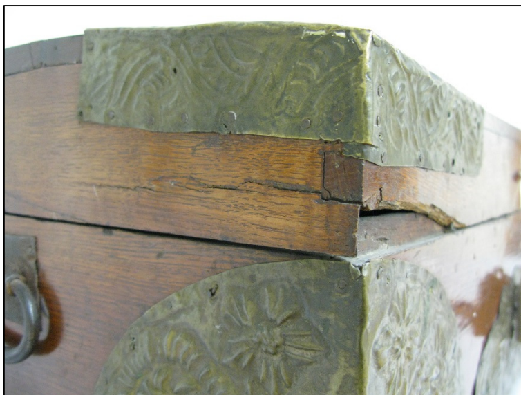
Samma skada från gaveln
