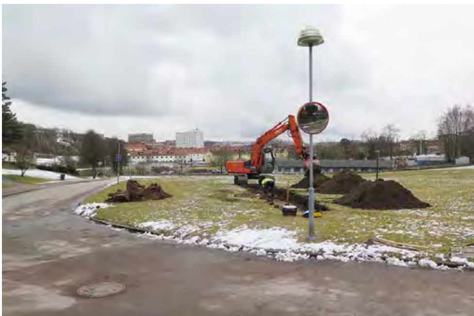
Figur 8. Schaktgrävning på fornlämnning Göteborg 79 våren 2016. Foto mot söder.
