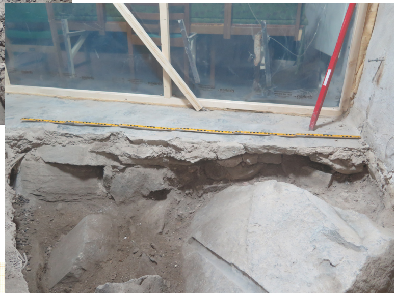
Figur 25. Översikt över schakt 2, mot öster.
