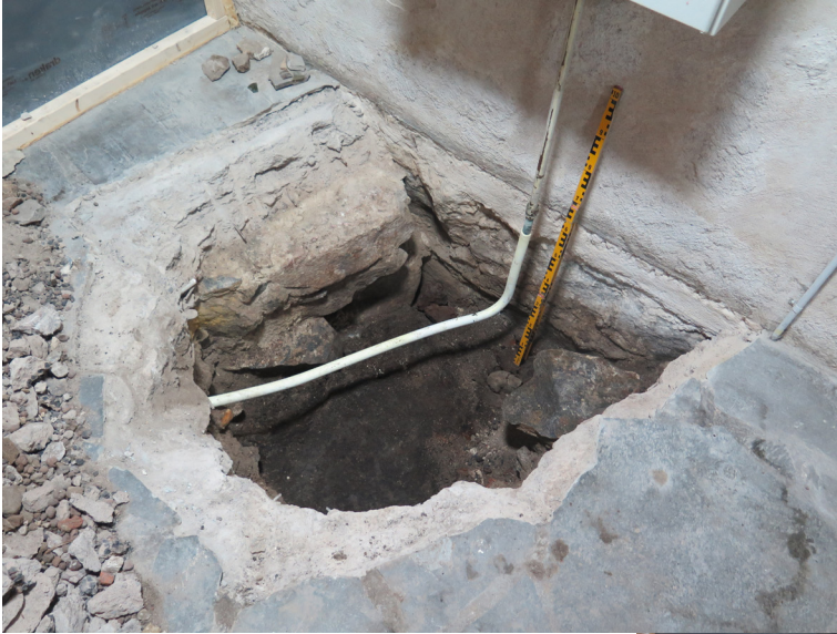
Figur 21. Översikt över schakt 1 grävd ner till ovankant matjordslager. Lagret kan eventuellt tolkas som ett äldre golvlager. I ovankant syns den äldre muren från Gullbergs fäste. Foto mot norr.
