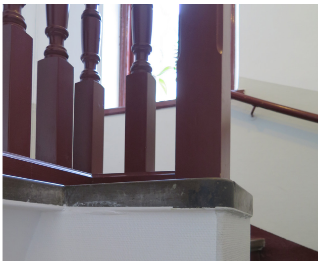
Räcke och kalkstensgolv på det östra trapphusets övre plan.
