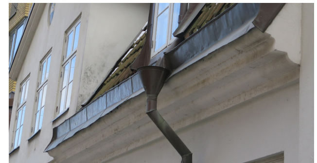
Den profilerade taklisten som löper längs husets långsidor.
