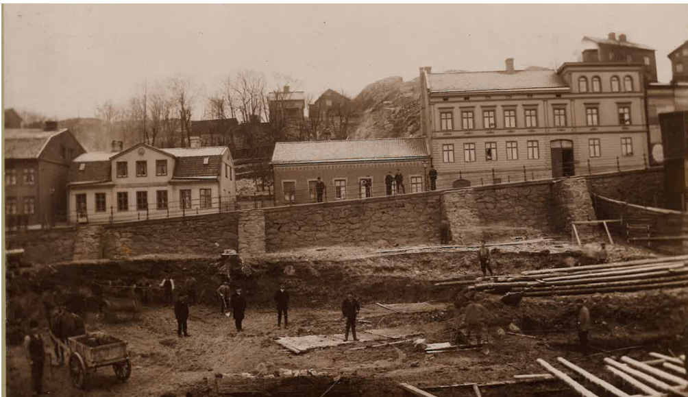
Sjömanshusets ännu två byggnader sett från norr medan Wettergrens affärskomplex uppförs.
