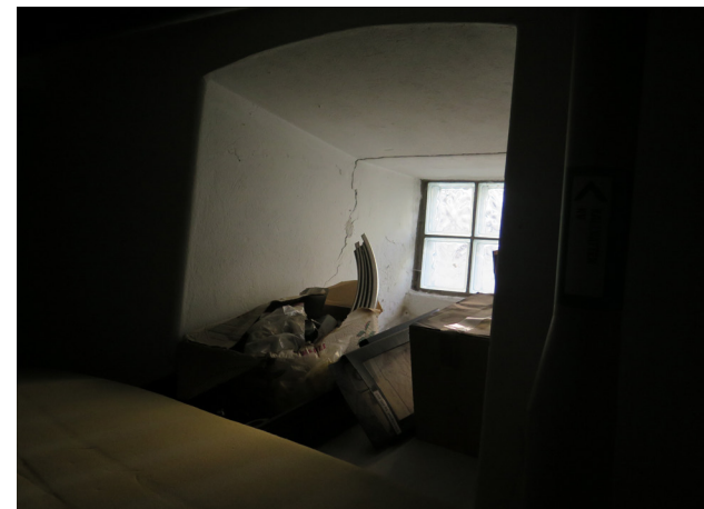
Nisch för källarfönster mot Stigbergsgliden.
