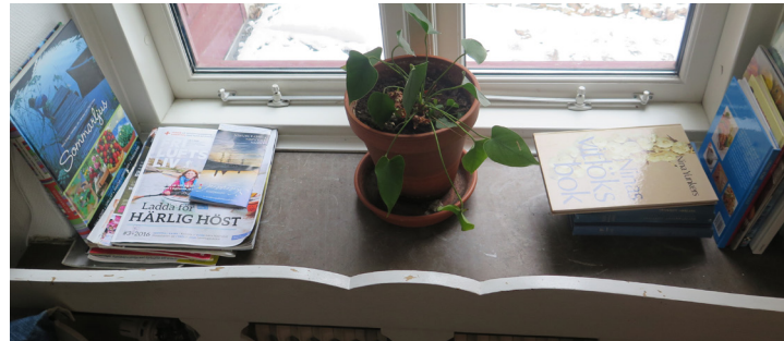
Fönsterbänk i kalksten i dagrum på bottenvåningen.
