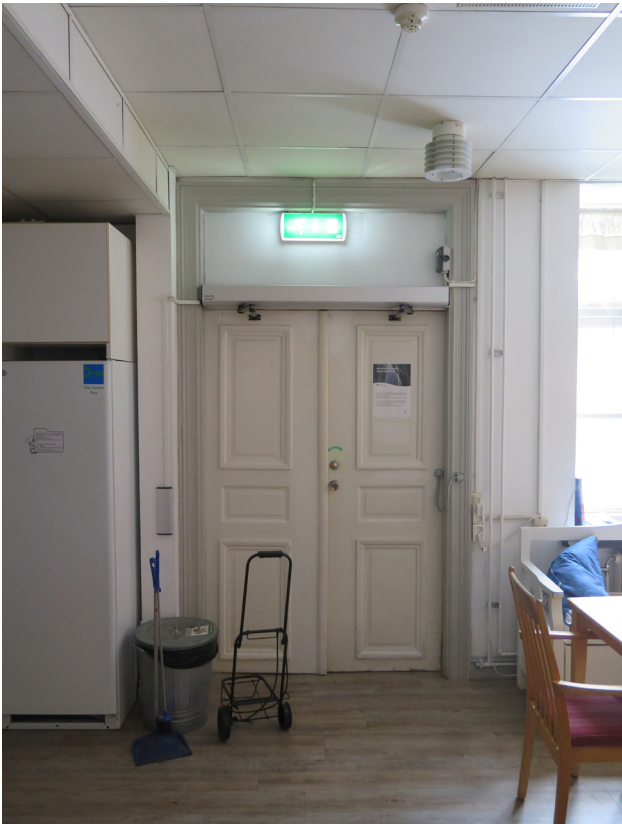
Äldre parspegeldörr med äldre profilerade foder på botten- våningen. Tidigare huvudentré till östra huset från gården.
