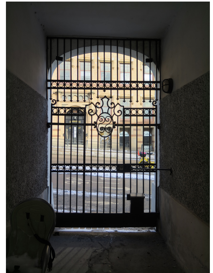
Den svartmålade järngrinden i portgångens öppning mot gatan. Grinden är rikt utsmyckad med pilspetsar och bårder med rundlar. Enbart delen under emblemet är öppningsbar.
