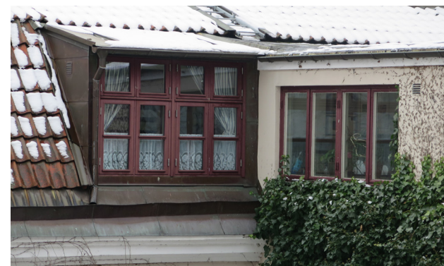
En av takkuporna och utbyggnadens annorlunda fönster.
