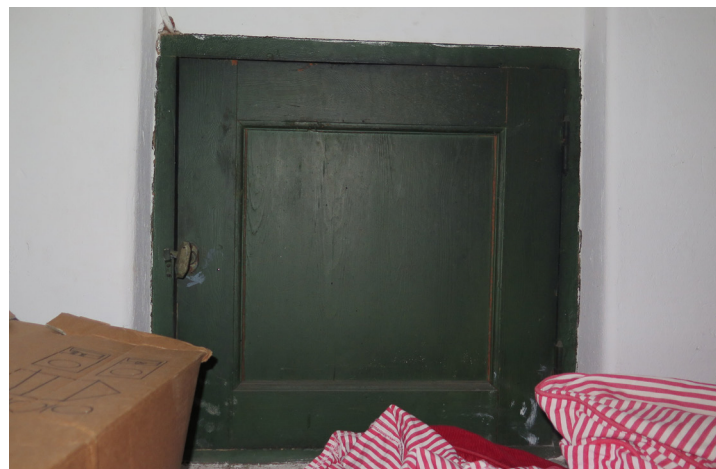
Äldre lucka till den outgrävda kryppgrunden, ådermålad i grönt.
