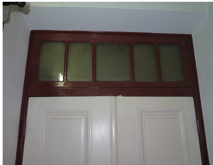
Överljusfönster över dörr på bild till vänster, sett från rum i utbygg- nad där fönstret ej täckts för.
