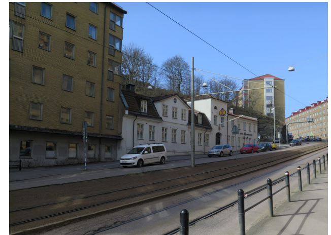
Sjömanshusets gatufasad sett från botten av Stigbergssliden.
