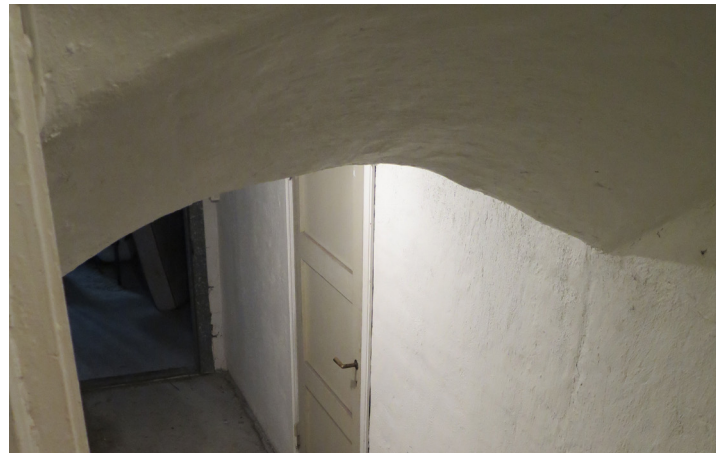
Valvbågen över trappan ner till källaren. Var tidigare den direkta ingången, från gården.
