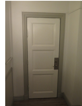
Äldre spegeldörr med profilerat foder i trapphus.
