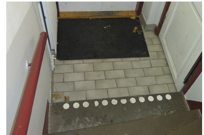
Det västra trapphusets entréplan.
