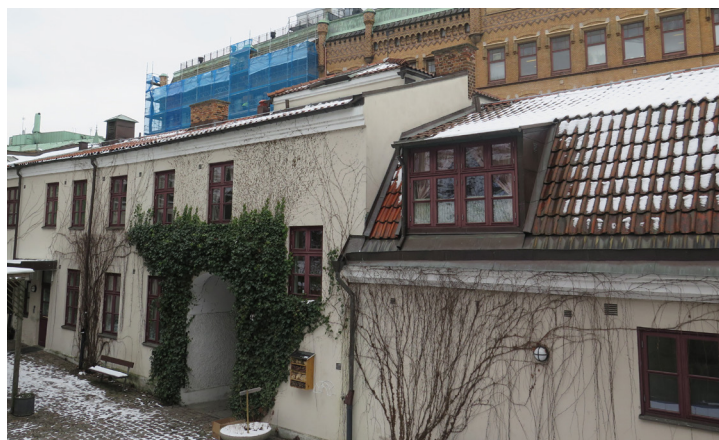
Mötet mellan de två delarna av byggnaden, sett från gårdssidan. Gavelpartiet åt öster gör att den västra delen upplevs som lägre.
