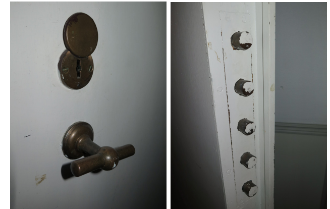
Bilder på de bevarade äldre vreden och låsanordningen i arkivdörren i metall på bottenvåningen. T.h. de kraftiga kolvar som låser dörren.
