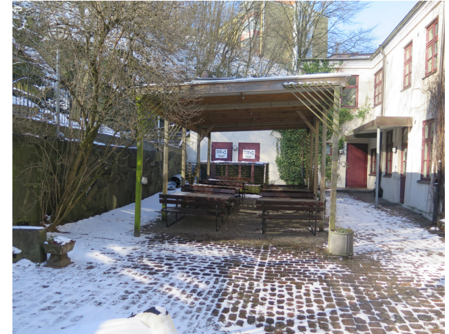
Innergården med gatstensbeläggning och taköverbyggnad i trä.
