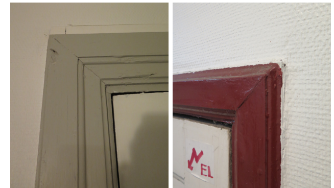
Två olika exempel på de bevarade äldre dörrfoder som finns i Sjömanshuset.
