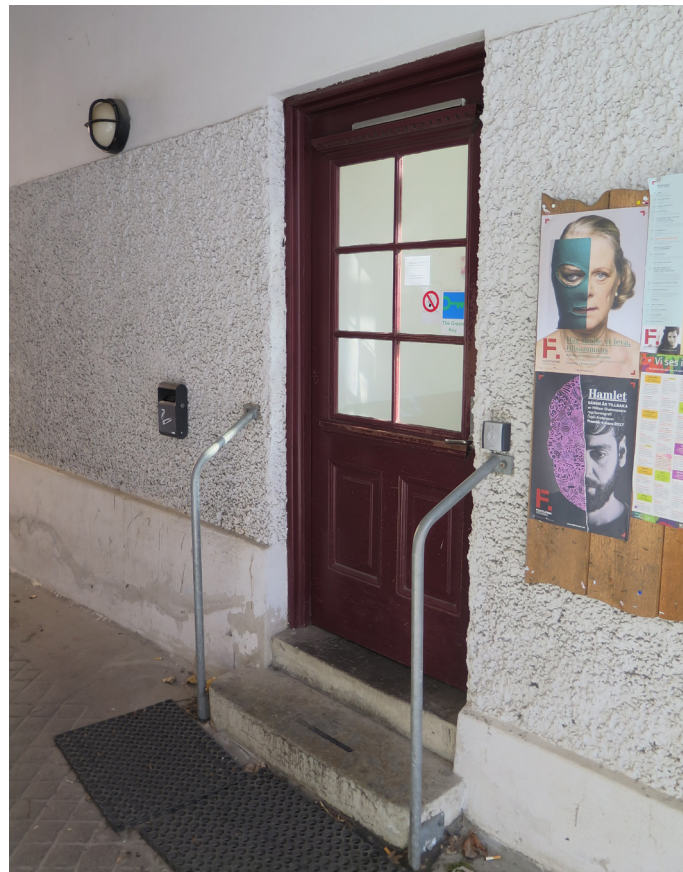
Trappan i kalksten och den glasade spegeldörren in till det östra trapphuset. På bilden syns även de spritputsade väggarna och hur underliggande gatsten syns igenom betongbeläggningen.
