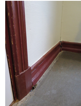
Äldre profilerade golvlister och dörrfoder.
