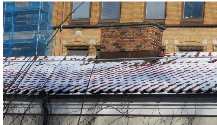
En av byggnadens tre murade skorstenar i rött tegel.
