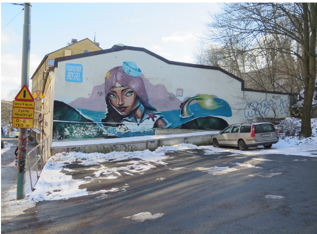
Byggnadens västra gavel med den stora grafittimålningen.
