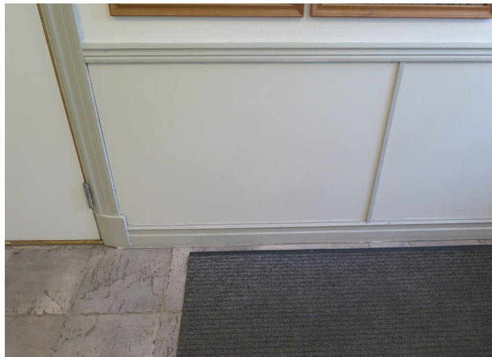
Detaljbild över klinkergolv och bröstningspanel i hallen intill lobbyn. Dörrfodren till vänster har äldre förlagor i huset som utgångspunkt.
