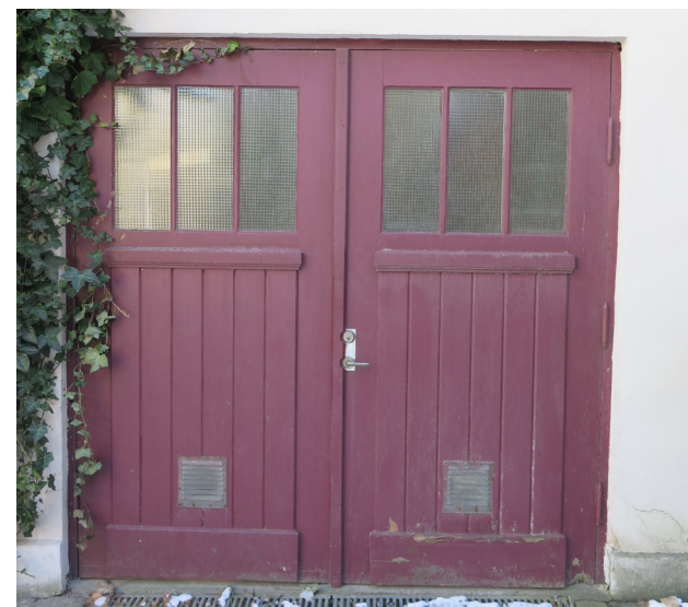
Utbyggnadens äldre glasade garagedörr.
