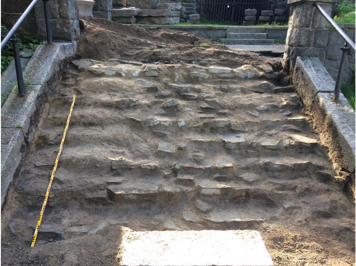
Figur 6. Övre delen av den nedre trappans grundläggning under trappstegsblocken.
