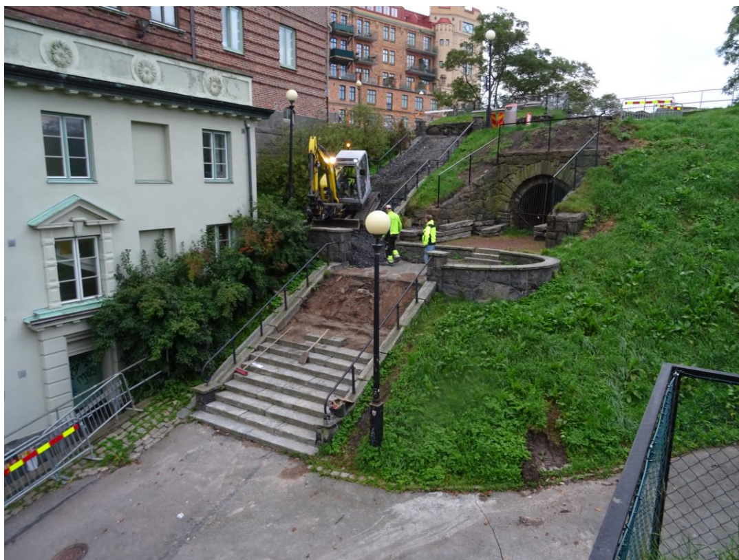
Figur 5. Översikt över den aktuella trappan vid renovering. Nedre delen av trappan är satt.
