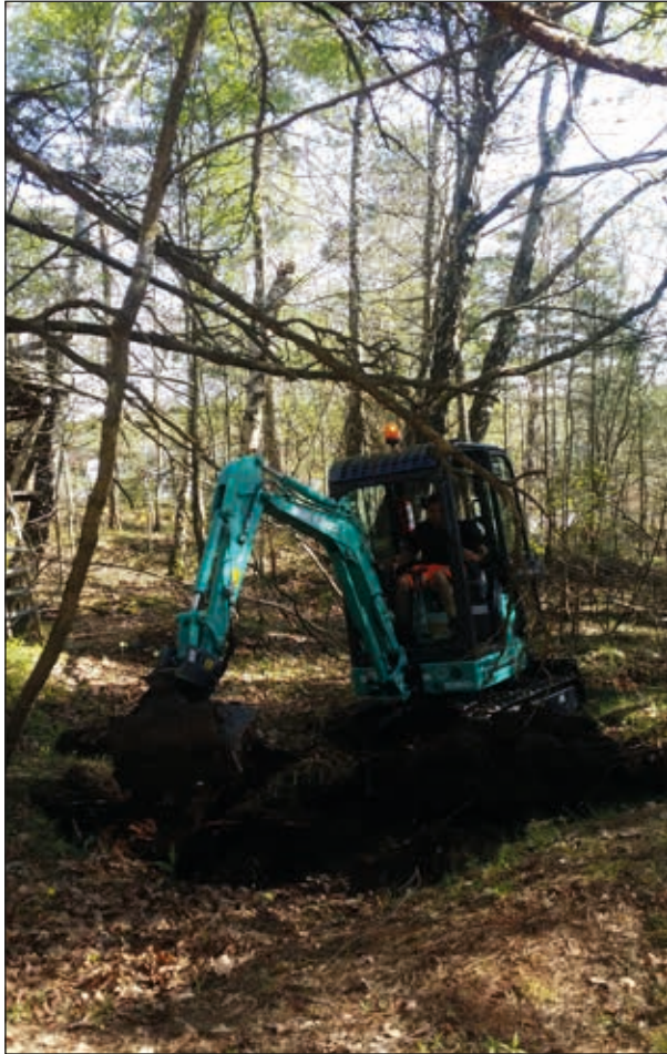
Figur 4. Schaktning i den del av utredningsområdet som gick att nå med grävmaskin.
