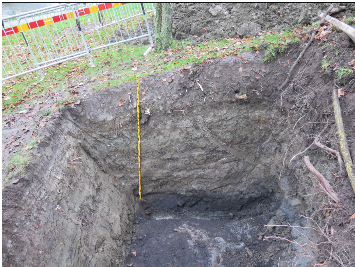
Figur 18. Östra profilen av schakt för pumpstation. Den mörkbruna humusen framkom under två meter av påförda omrörda lermassor och tolkas tillhöra ravelin Prins Ulrik. Foto mot öster.
