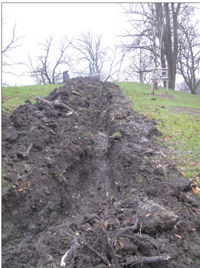
Figur 17. Ledningsschaktet fram till pumpstationen var ca 0,5 meter djupt och grävdes främst i humösa lager, mot sydväst.
