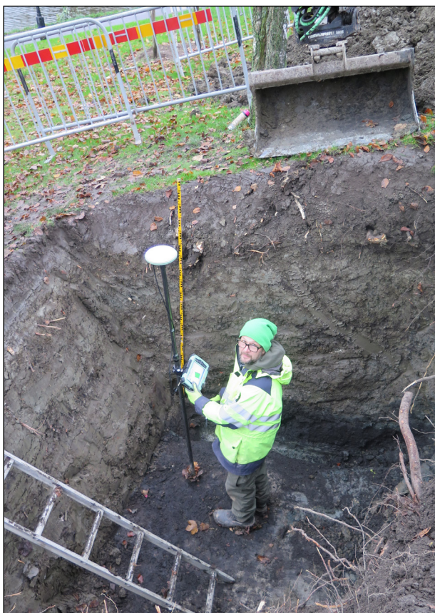
Figur 19. Schakt för pumpstation vid dokumentation av Andreas Morner Åhman. Foto mot öster.
