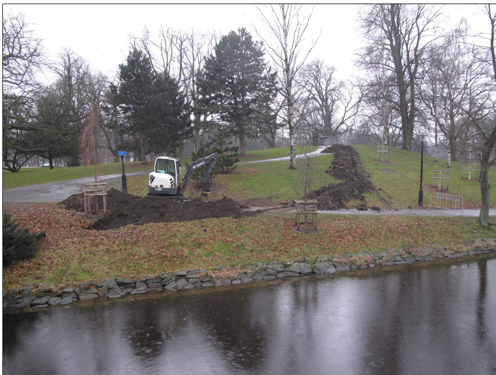
Figur 16. Översiktsbild över ledningsschaktet upp på Floras kulle, mot sydväst.
