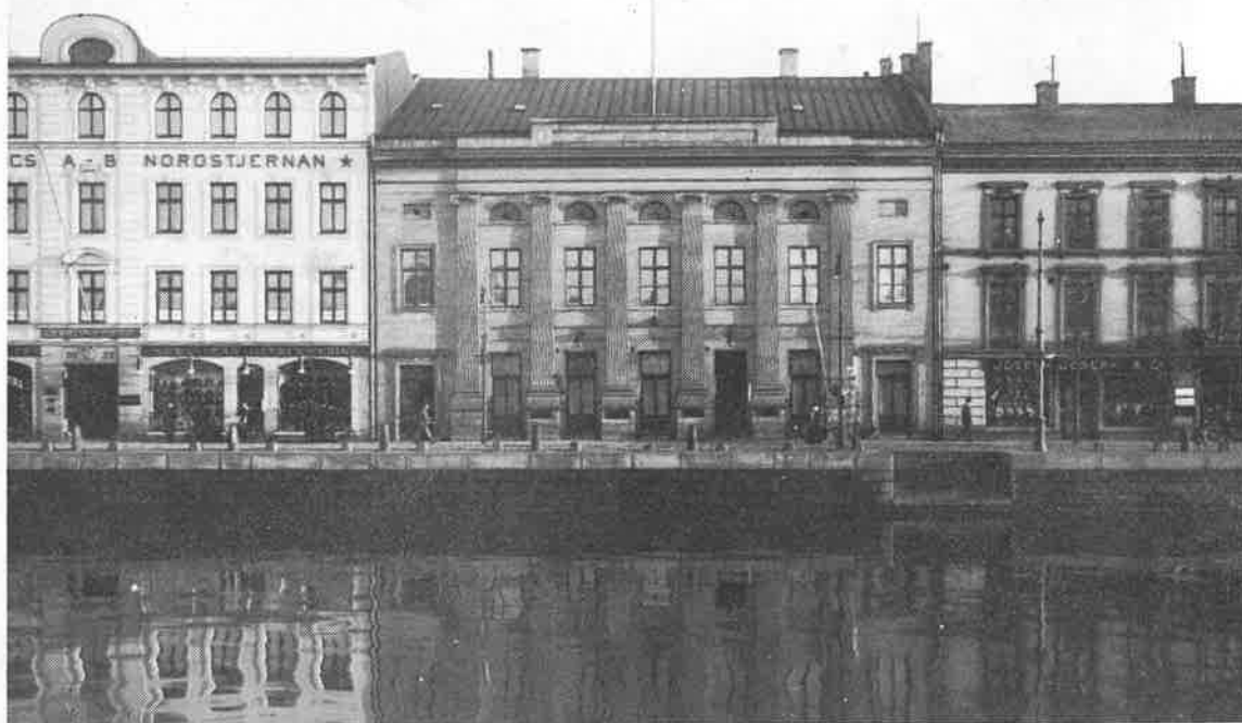
Fasad mot S.Hamngatan före ombyggnaden 1916-18 Fig 9.
