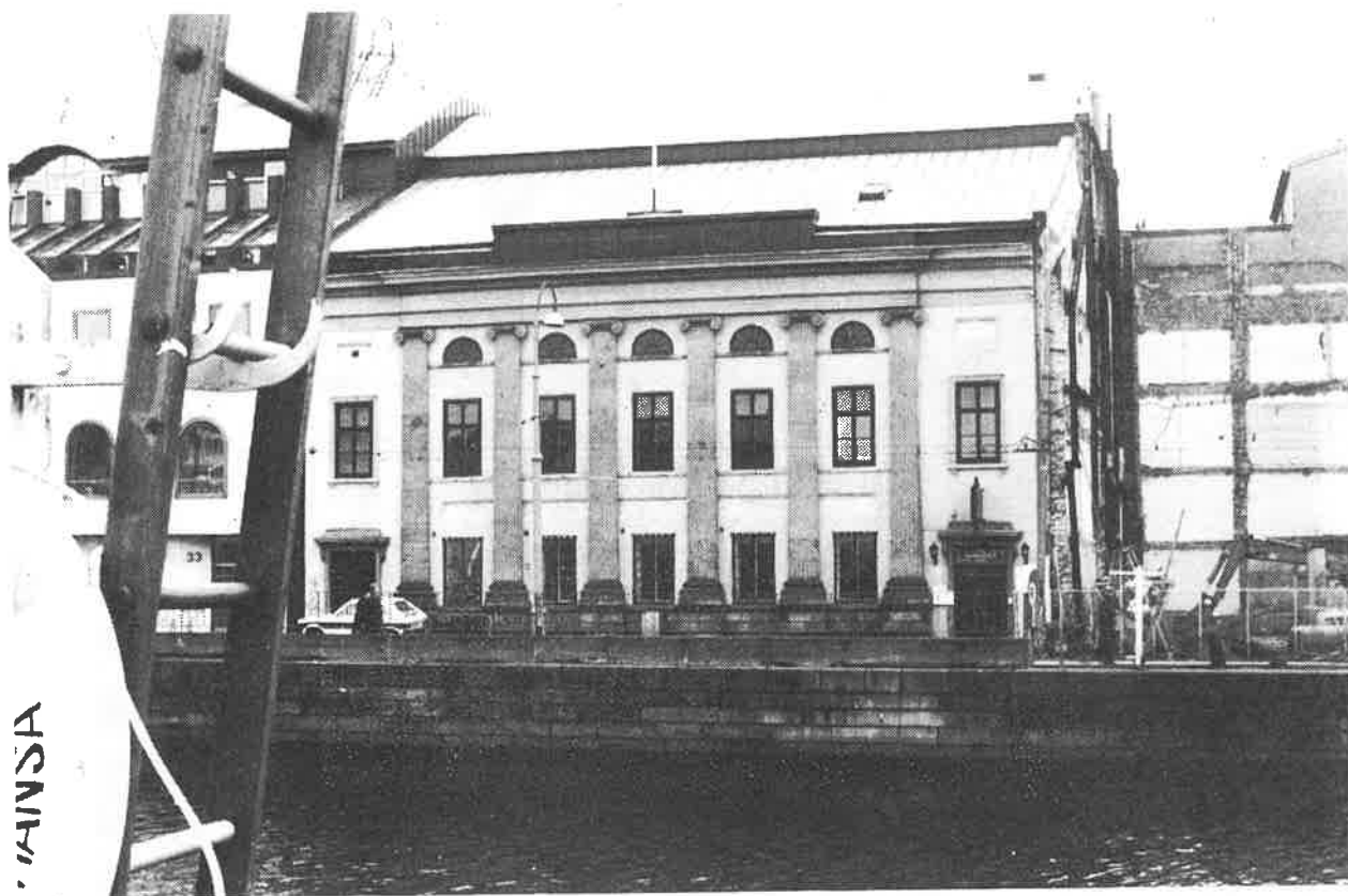
Fasad mot S. Hamngatan
