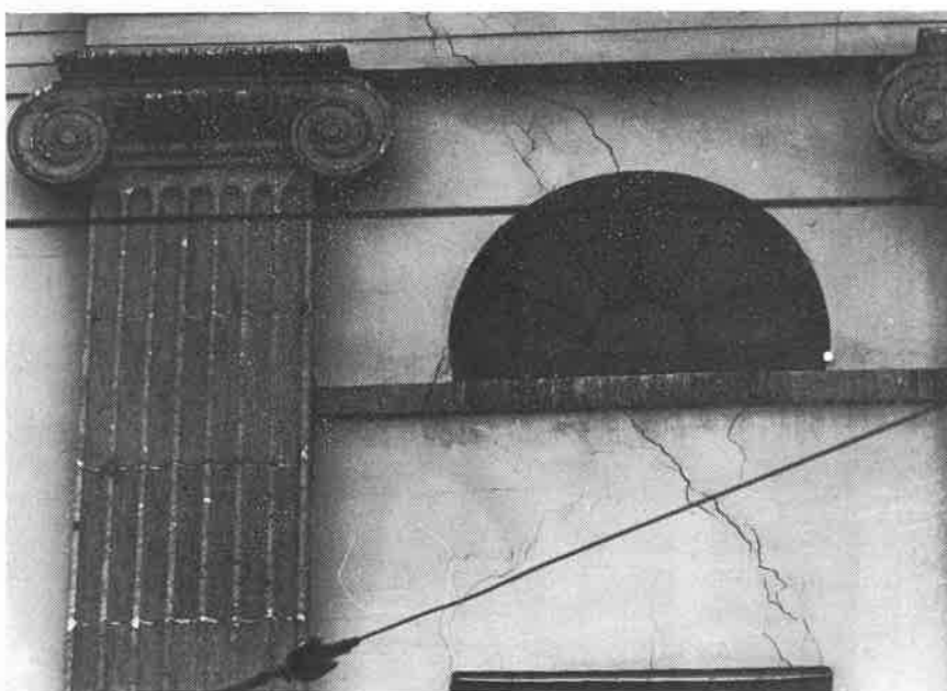
Fasaddetalj visande joniskt pilasterkapitel.
