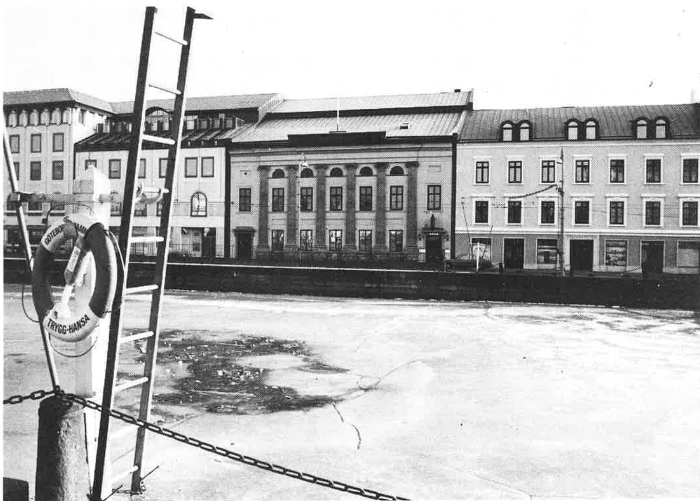
Fasad mot norr år 1981, foto TH.
