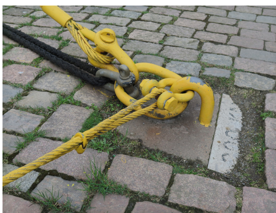
Olika typer av förtöjningsanordningar är placerade längs hela kajens sträckning
