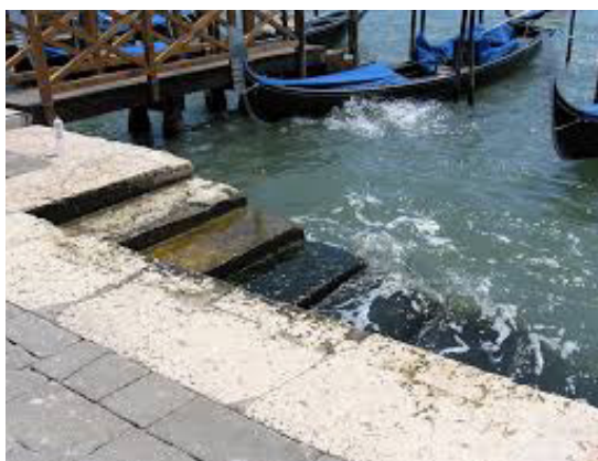
Exempel från Venedig på trappa som leder från kaj ner till vattnet. Källa:
