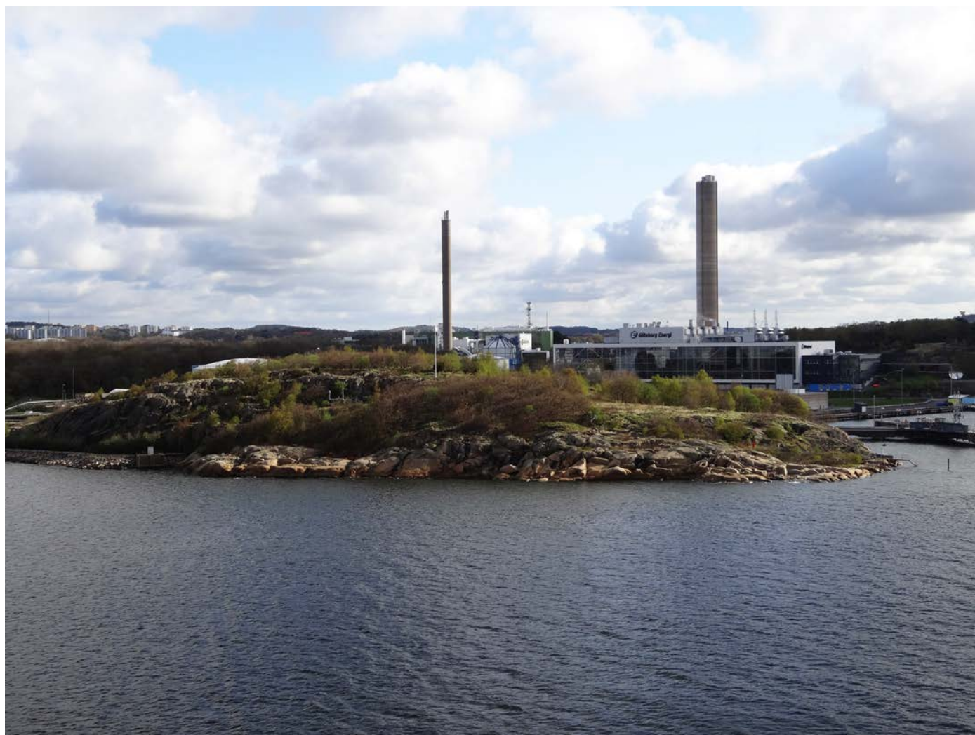
Figur 46. Rya Nabbe och Rya kraftvärmeverk från Nya Varvet i söder.
