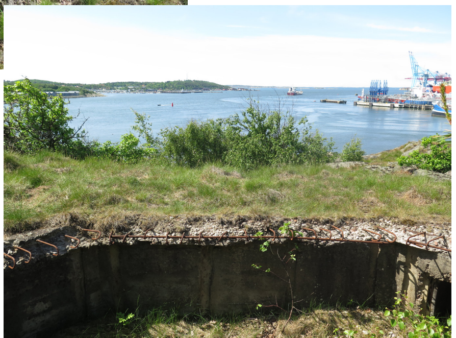
Figur 22. Det nordvästra kanontornet med utsikt mot farleden och hamninloppet mot väster. Tornet är uppfört i betong och uppfört under 1900-talet. Foto: Tom Wennberg.
