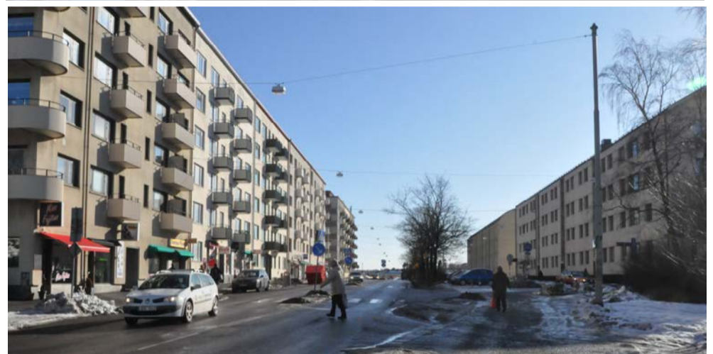
Ovan: Övre Johannebergs möte med Gibraltarargatan idag. Butiker vetter mot gatan, gatten upp mellan husen ger längre utblickar.
