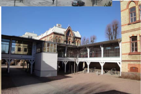
Mellan byggnaderna löper ett modernt hårdgjort stråk.
