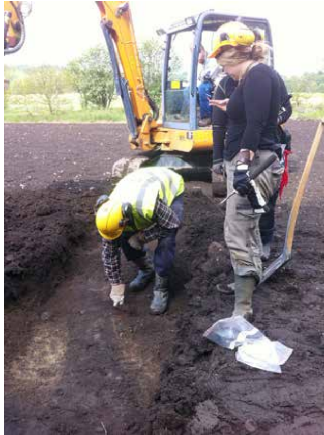
Figur 5. Schaktgrävning på boplatsytan.
