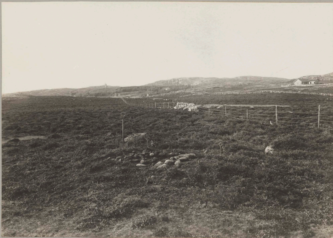
Fot. 3. Roset i utgrävningen rengjort. Spade ställd vid v. sidan av utgrävningen. Den stora hållristningen t. h. om stugan i mitten under kvarnen. Sett från SÖ. (334.) D 1211 G. Parauw foto.
