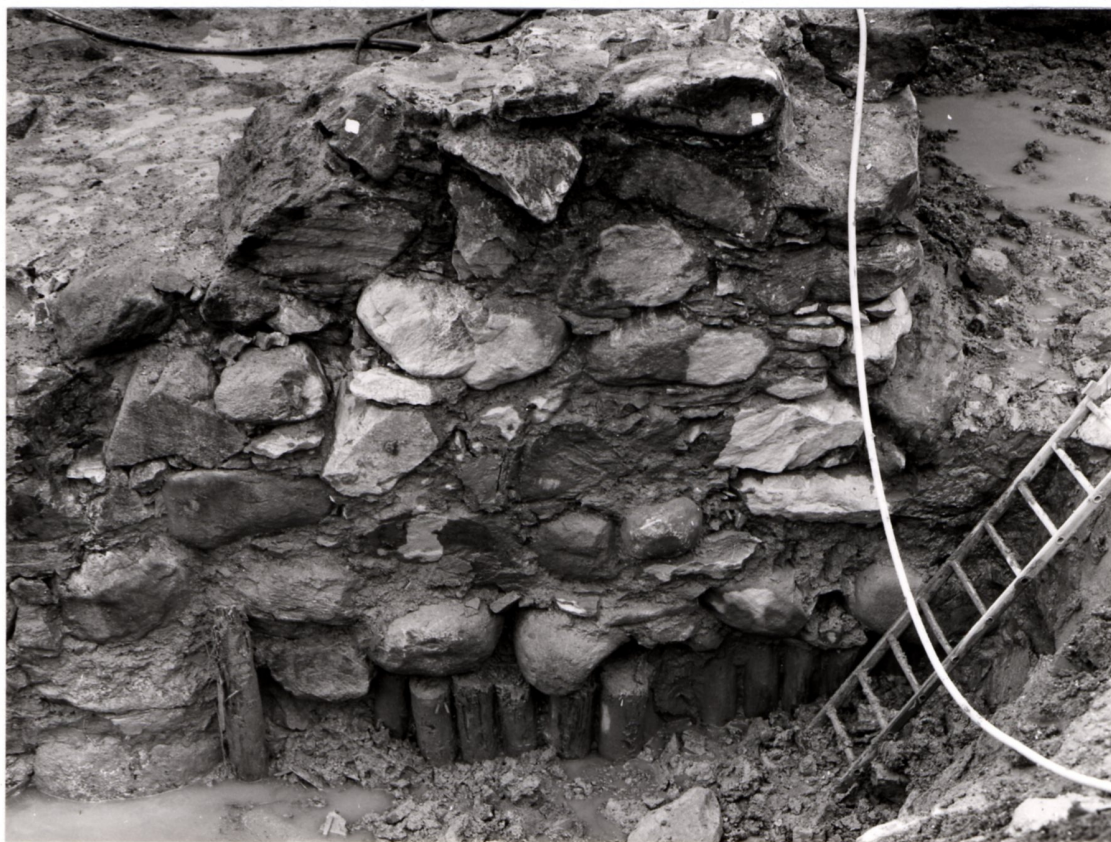
Fig 9. Foto Lars Noord Kv Saluhallen 4, 6, 7. Pålar under kurtinens kortsida, mot sydväst.
