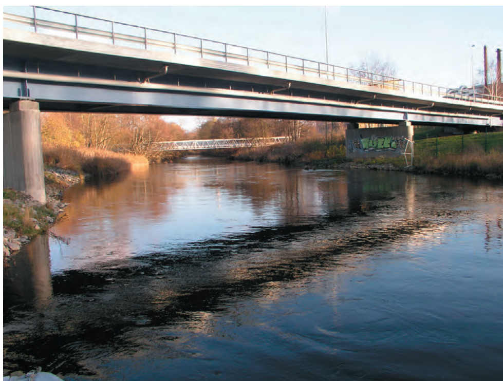
Fig. 6. Sävån vid Kvibergsbron omedelbart söder om Kvibergs garnison. Notera erosionsskyddet i form av sprängsten till vänster i bild (norra stranden). Foto: Jens Lindström/Bohusläns museum.
