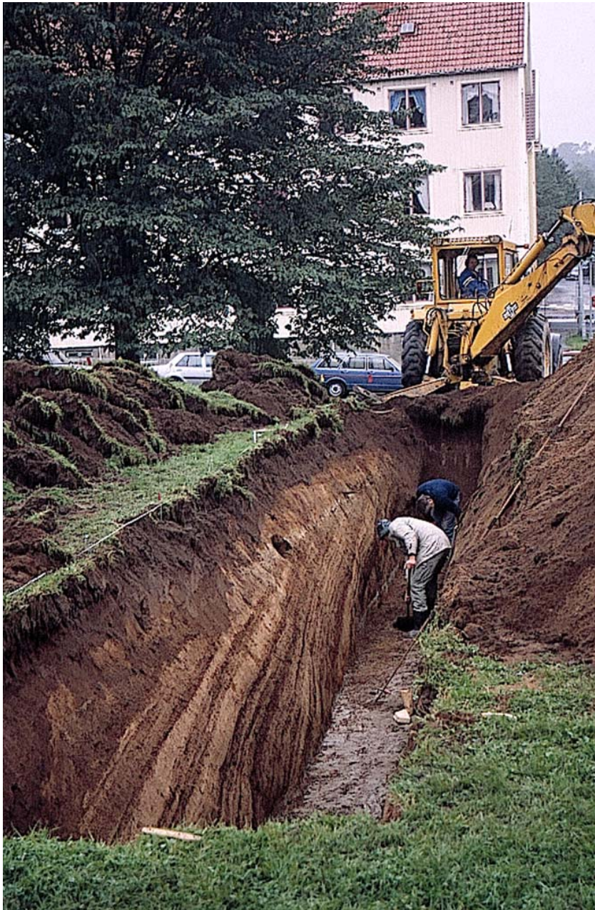
Fig. 4. Gö 15. Det maskingrävda schaktet. Foto från NV.
