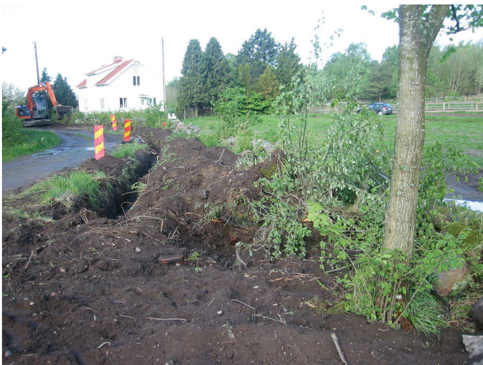
Fig. 4. Schaktkontrollen öster om boplatsen Bj 374 utfördes i kanten av en väg. Foto mot sydväst.
