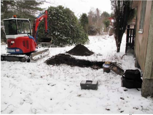
Fig. 6. Pågående grävning av schakt 1. Foto mot Ö.
