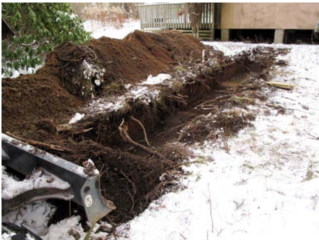
Fig. 7. Fortsatt grävning av schakt 1. Foto mot SO.
