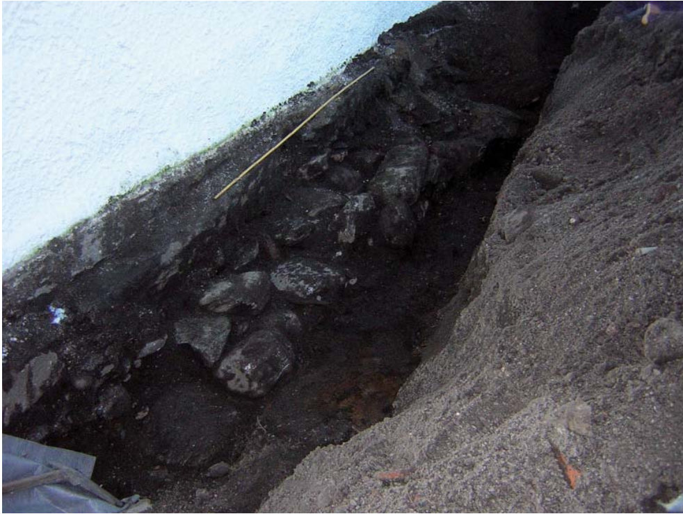
Figur 13. Grundkonstruktionen av långhusets norra vägg, mot SV. Foto: Tom Wennberg.
