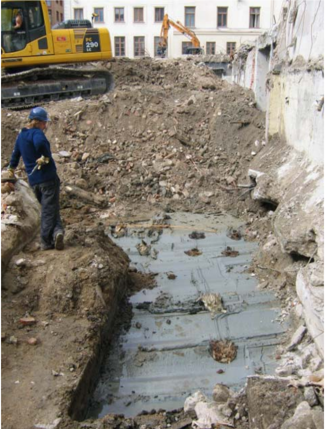
Bilaga 4. Ögonblicksbild vid schaktning, mot väst. De omnämnda pålarna syns i den postglaciala leran. Arkeolog Johannes Nieminen syns i bild.
