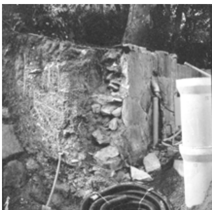
Fig 12. Detaljfoto över fyllnads-massor mot flankmuren, mot NV. Foto: Staffan Westergren.
