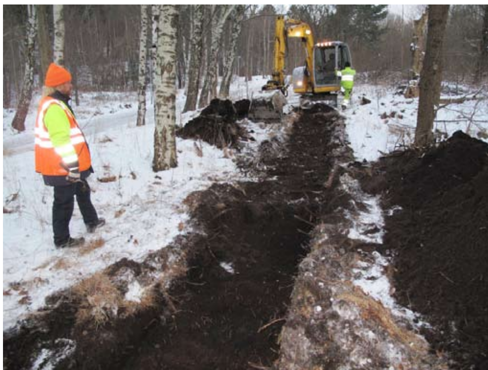
Figur 8. Grävning av schakt 1 på fornlämning Göteborg 464. Foto mot norr.
