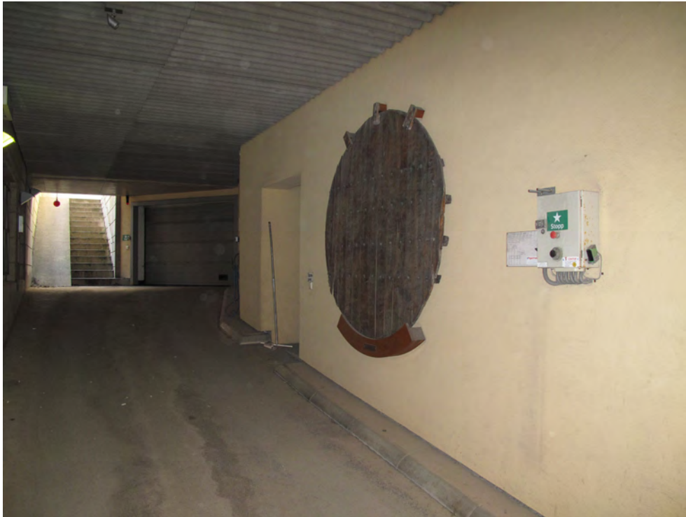
Figur 28. Tunnbotten A8 monterat i portgången i studentbostaden.
