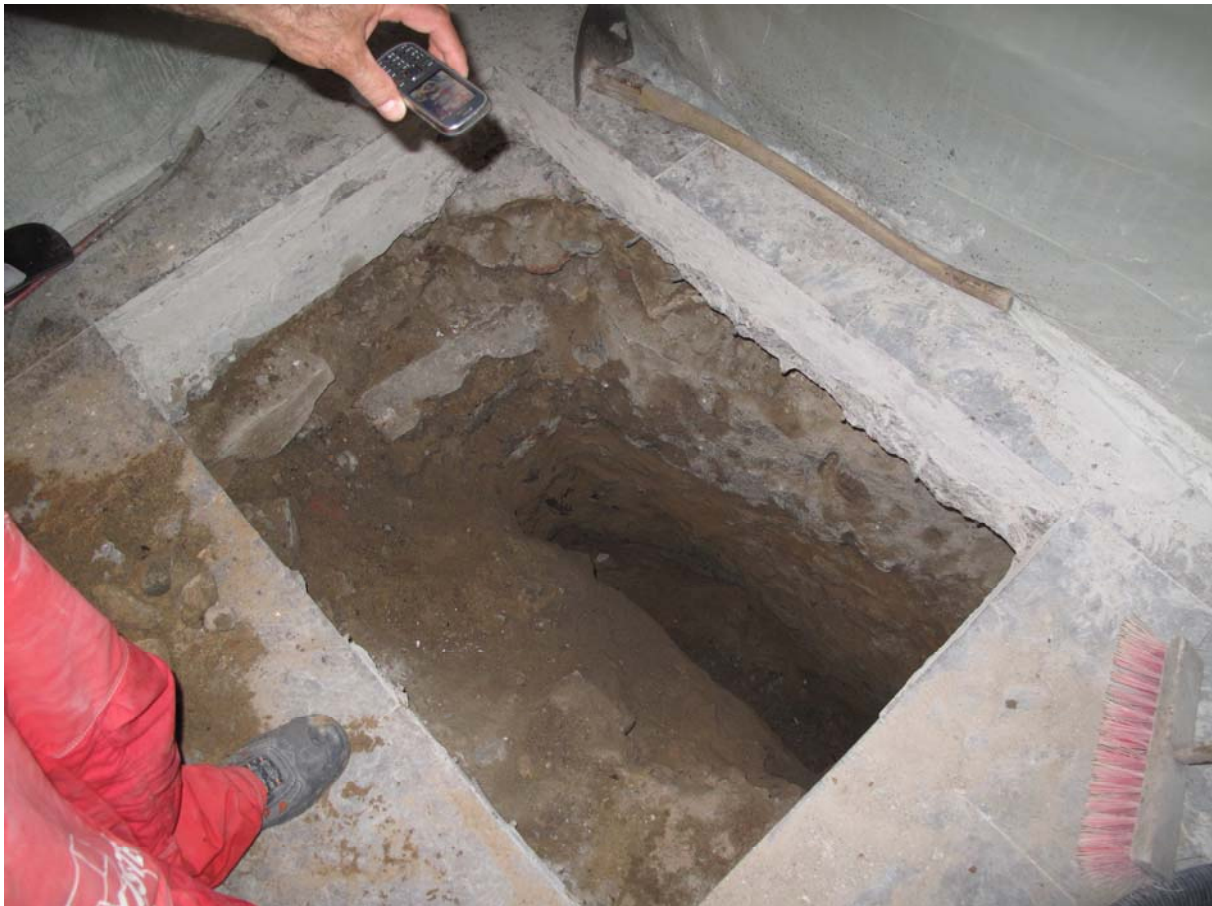
Fig 4. Provschaktet med tornets grundmur i bakkant och den nypåträffade muren till höger.
