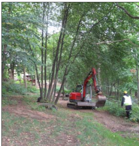
Figur 12. Läget för schakt 3 i dalgången söder om gläntan. Foto mot norr.
