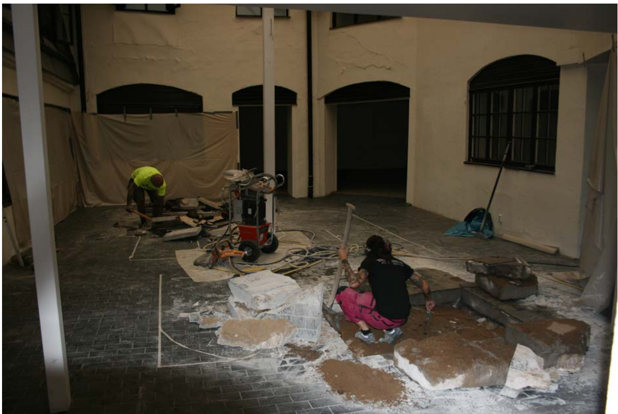
Figur 5. Den inglasade innergården mot söder. Provschakt 2 i bildens framkant.
