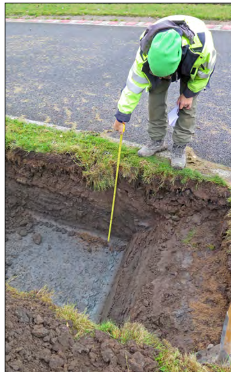
Figur 10, till höger. Schaktning under hösten 2014. Andreas Morner Åhman i bild.
