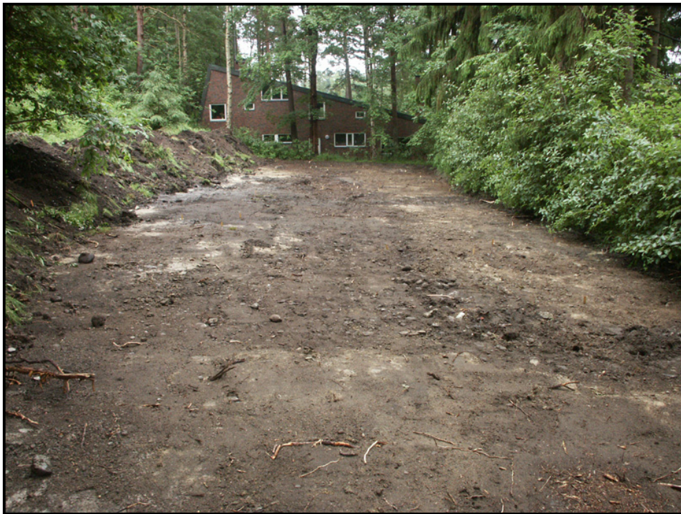
Figur 4. Undersökningsområdet mot söder efter inledande matjordsavbanning. Foto AC2007-17-O-0080. Jfr figur 3.
