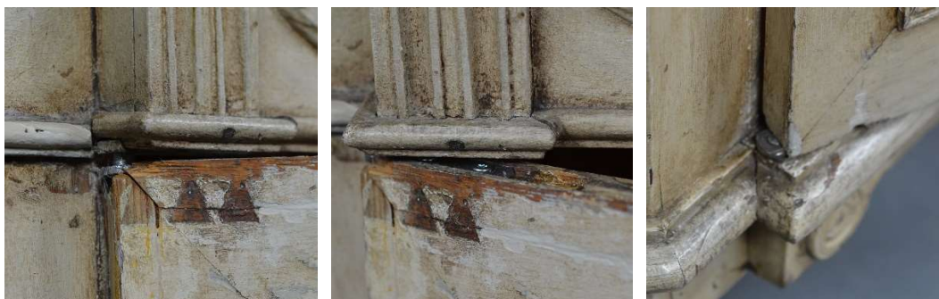
De nya gångjärnsdelarna kan skymtas, inga försök att få dem att se gamla ut har gjorts.
