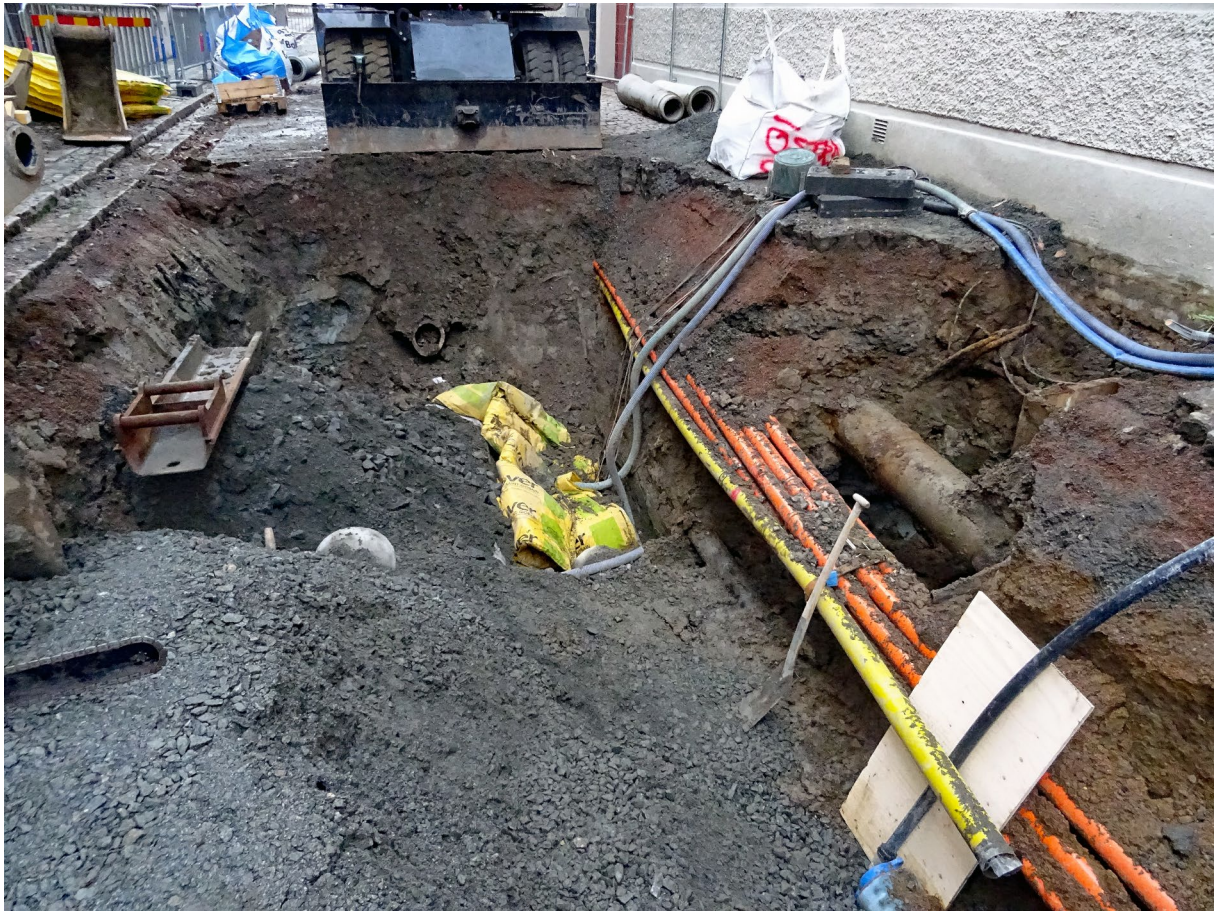
Figur 4. Översiktbild under pågående schaktning längs Östra Skansgatan. Foto mot norr.
