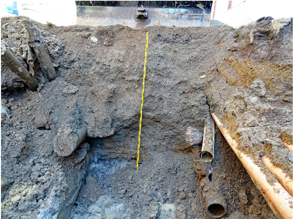
Figur 5. Profilbild tagen i samband med schaktningen. Längs östra och västra schaktkanten är äldre ledningar synliga. Foto mot norr.
