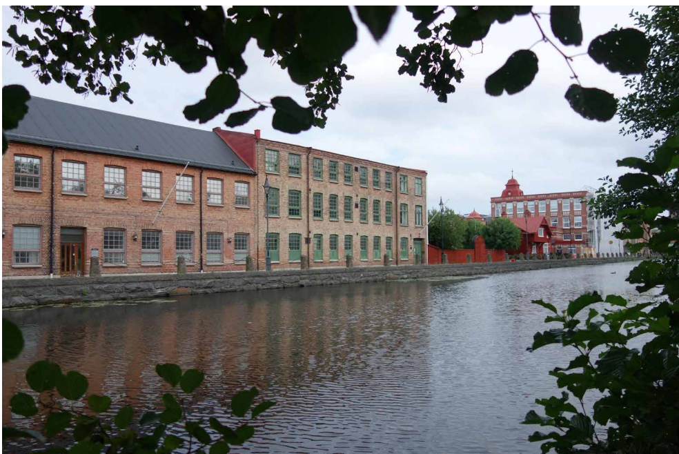
Stråket Mölndalsån mellan Liseberg och Stora Katrinelund. På landerierna bedrevs småindustrier. Remfabriken i Gårda från 1900-talets början visar på industriernas kontinuitet längs stråket.
